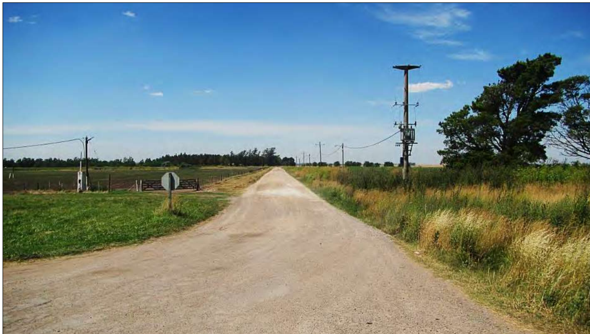
18 - P7. (37.322011° S / 59.966226° O). La Alternativa Centro (verde) transcurre desde la ET del Parque Eólico paralela al alambrado y a camino rural.
