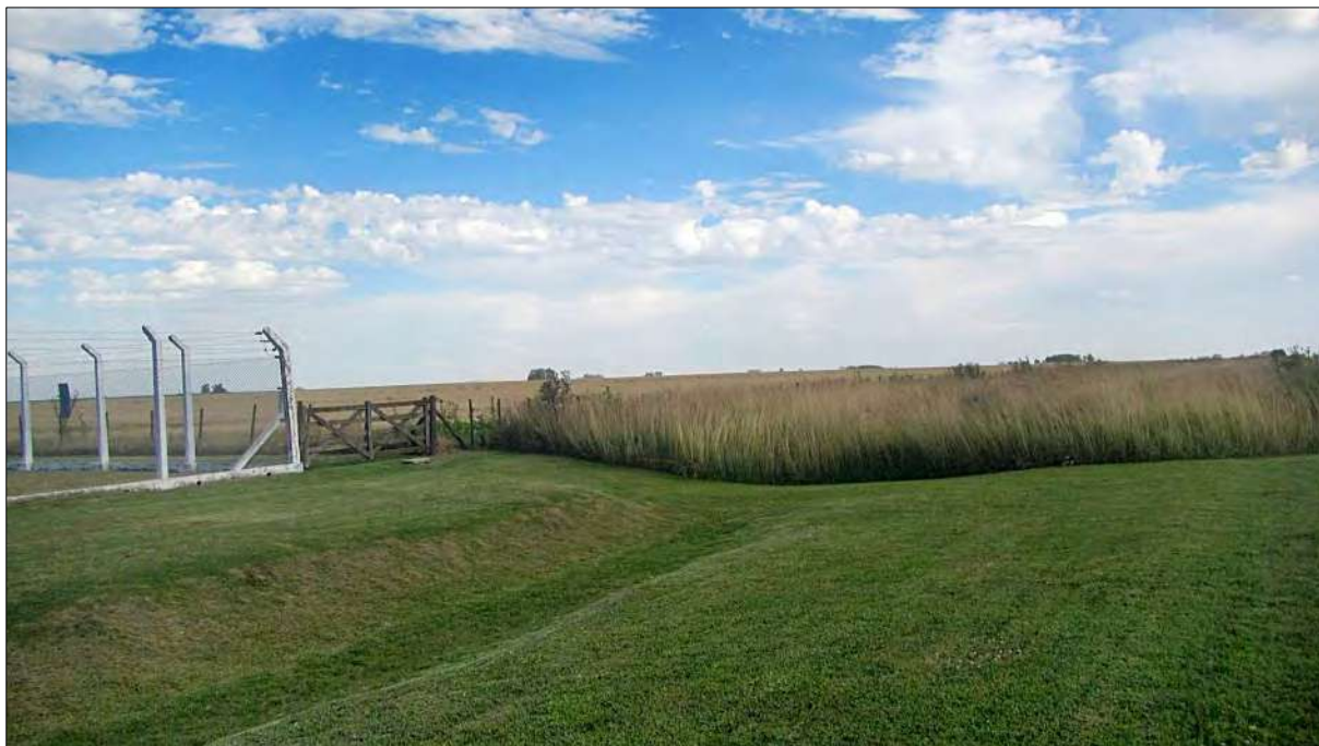
40 - P15. (37.300525° S / 60.117792° O). Sector de acometida de la Traza Sur (azul), contiguo a la ET existente.
