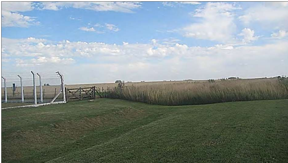
42 - P15. (37.300525° S / 60.117792° O). Sector de acometida de la Traza Sur (azul), contiguo a la ET existente.
