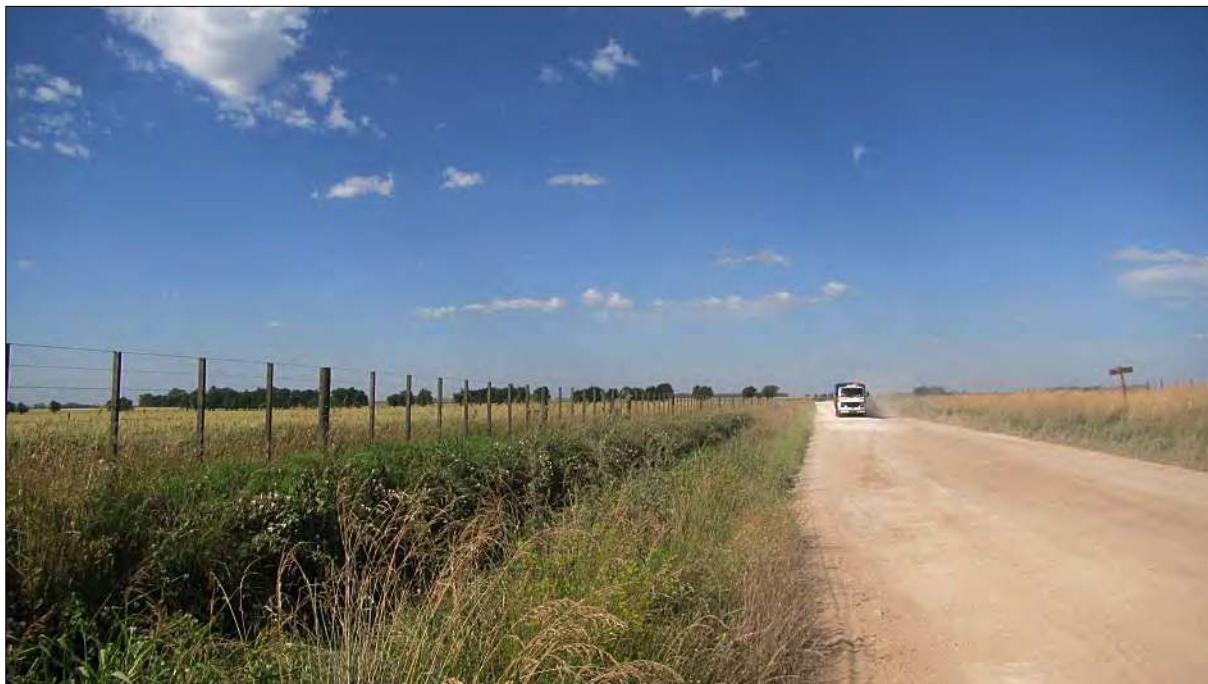
9 - P12. (37.308135° S / 60.027884° O). La Alternativa Norte (roja) transcurre desde la ET del Parque Eólico por dentro del campo, paralela al alambrado y al camino rural. Vista hacia el Parque Eólico.
