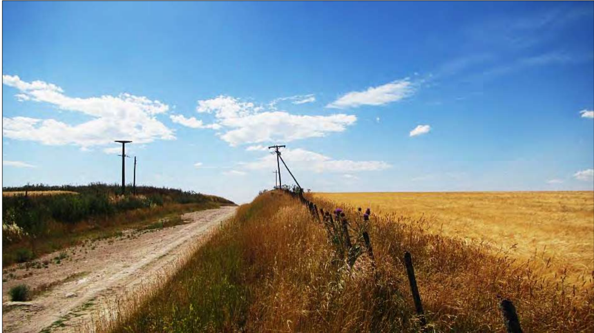
26 - P10a. (37.337195° S / 59.990956° O). La Alternativa Centro (verde) transcurre, hacia la ET Chillar por dentro del campo, paralela al alambrado y al camino rural.
