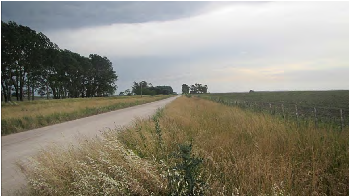
13 - P5. (37.352494° S / 59.800107° O). La Alternativa Centro (verde) transcurre hacia la ET Chillar por dentro del campo, paralela al alambrado y a camino rural. 500 m más adelante esta alternativa presenta interferencia con el edificio de una vieja escuela rural abandonada y habitada.
