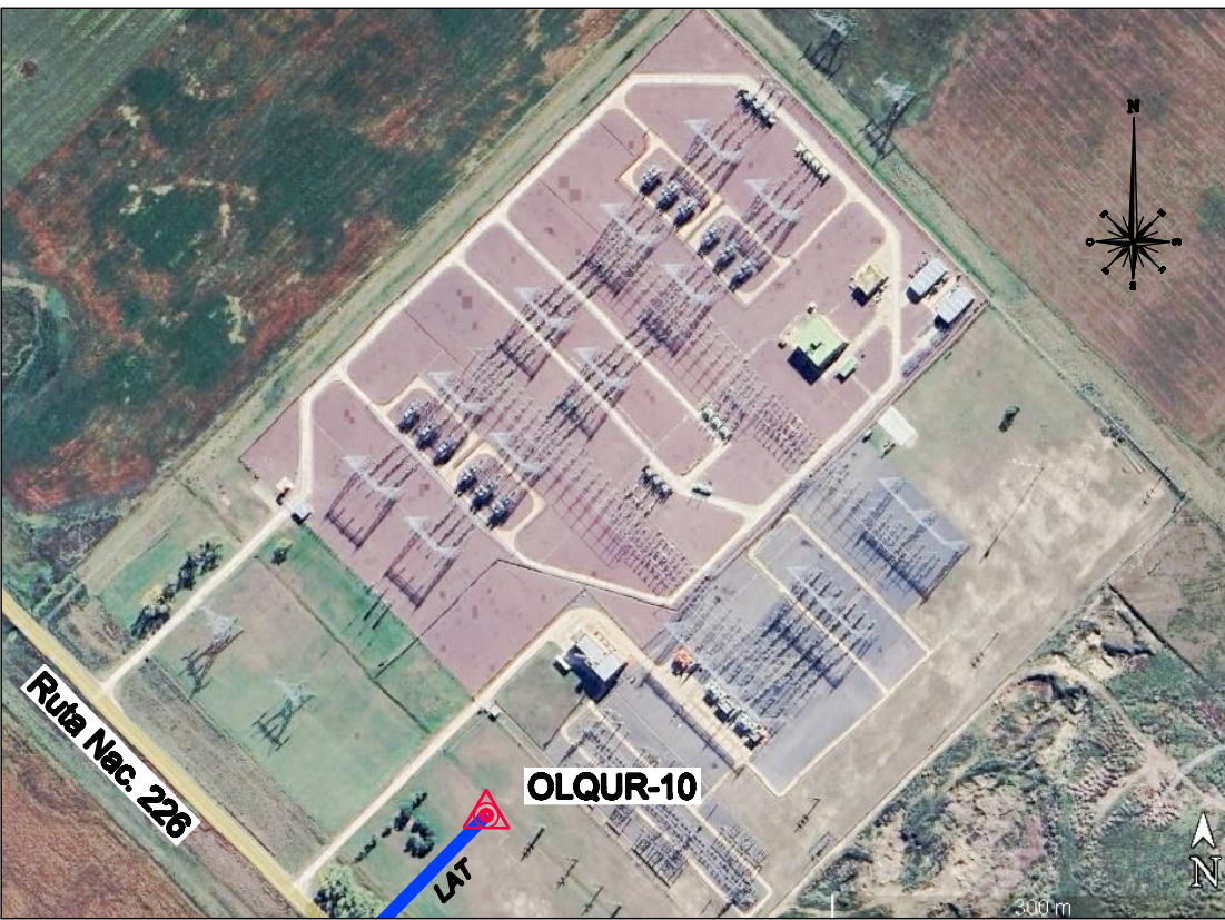
ESTACIÓN TRANSFORMADORA OLAVARRÍA
