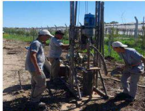
Fotografía 2. Perforación para construcción del Pozo de Monitoreo F4
