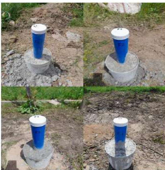
Fotografía 3. Pozos de Monitoreo construidos
