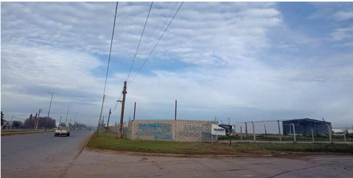
Imagen 2: Intersección de la Av. 520 y calle 197, Abasto.
