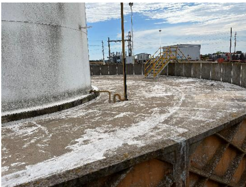
Imagen 2. Vista del suelo impermeabilizado, zona de tanques en desuso.
