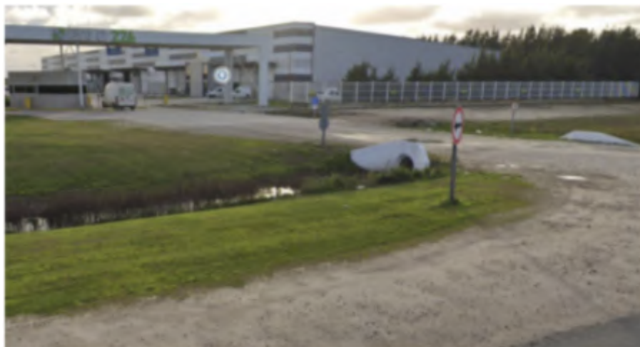
Figura N°10: Alcantarilla lateral sobre préstamo de ruta
