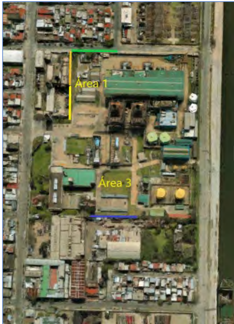
Figura 11. Muros preexistentes en CDS
