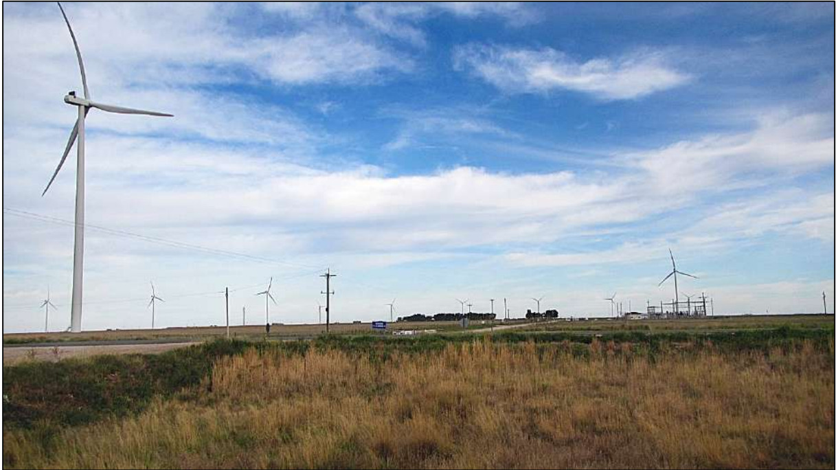
Sitio 1 (38,57539°S 61,92127°O). Cruce de la Ruta Provincial 51. La traza de la Alternativa 1 (verde) cruza la Ruta Provincial 51 e ingresa al Parque Eólico La Genoveva para alcanzar la LAT 132 kV La Genoveva-Bahía Blanca. Vista de la traza de la Alternativa 1 (verde) hacia la Ruta Provincial 51.
