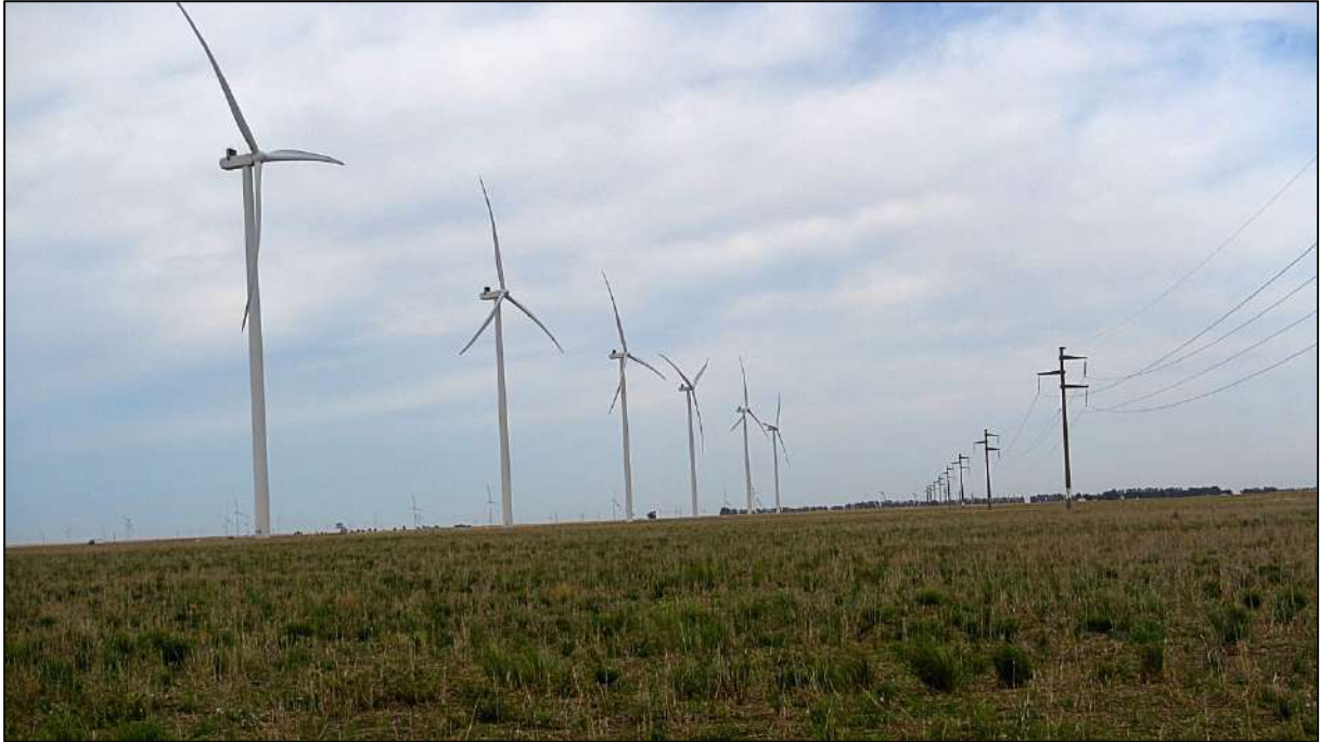
Sitio 2 (38,57227°S 61,92529°O). Vista de la LAT 132 kV La Genoveva-Bahía Blanca. La traza de la Alternativa 1 (verde) transcurre paralela a esta línea hacia la ET Bahía Blanca, a campo traviesa dentro del predio del Parque Eólico La Genoveva.
