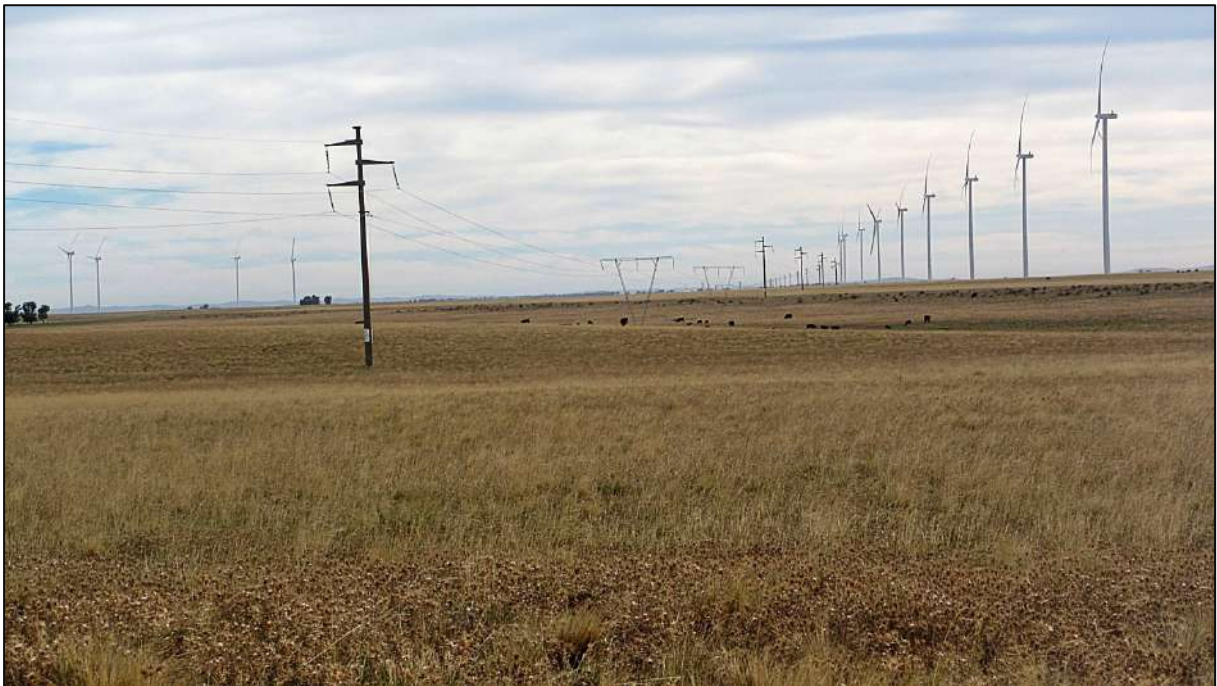
Sitio 6 (38,5934°S 61,95269°O). Alternativa 1 (verde). Vista de la traza hacia la ET Napostá Chico a campo traviesa, paralela a la LAT 132 kV La Genoveva-Bahía Blanca.
