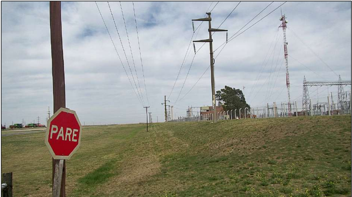
Sitio 13 (38,65901°S 62,04943°O). Ambas alternativas, Alternativa 1 (verde) y Alternativa 2 (roja). Vista de la traza subterránea hacia la acometida final en la ET Bahía Blanca, sector TRANSBA. La traza sigue paralela a la línea La Genoveva-Bahía Blanca, por zona de camino de la Ruta Provincial 51. Fotografía tomada desde el camino de acceso al sector TRANSENER de la ET Bahía Blanca.
