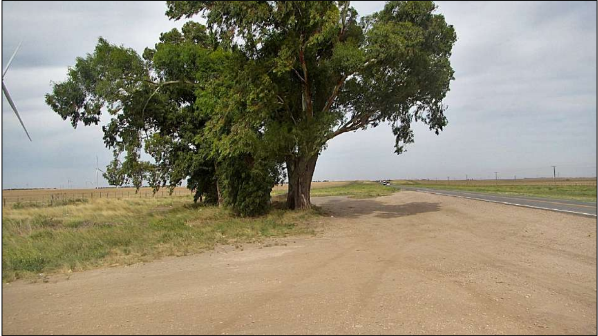
Sitio 18 (38,63024°S 61,98881°O). Alternativa 2 (roja). La traza transcurre por zona de camino de la Ruta Provincial 51. Vista hacia la ET Bahía Blanca.
