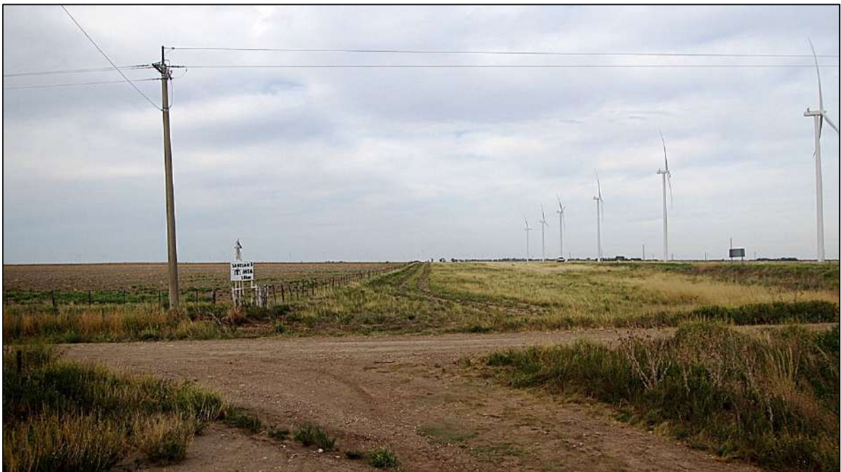
Sitio 1 (38,57539°S 61,92127°O). Cruce de la Ruta Provincial 51. Vista hacia la ET Bahía Blanca. Ambas trazas se separan. La traza de la Alternativa 2 (roja) no cruza la Ruta Provincial 51, se dispone por zona de camino paralela a la ruta.
