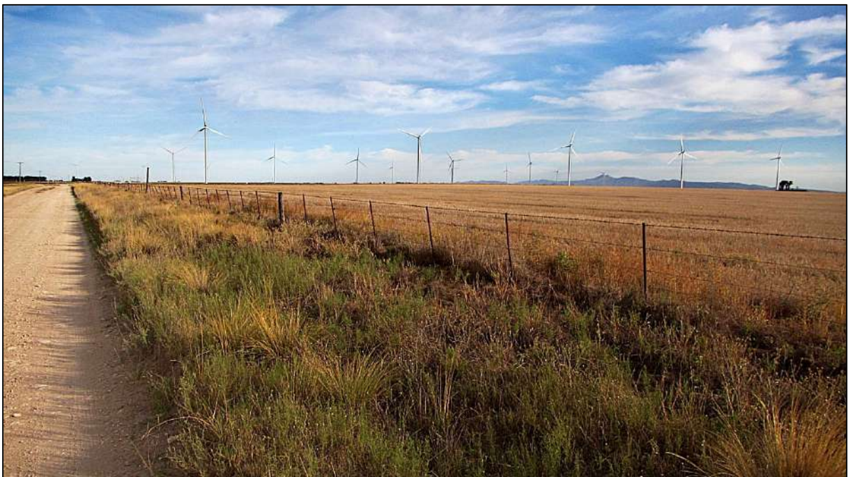
Sitio 0 (38,58398°S 61,91028°O). Inicio de la traza de ambas alternativas, Alternativa 1 (verde) y Alternativa 2 (roja) en la ET Napostá Chico del Parque Eólico Los Alamitos. La traza transcurre dentro del predio del parque eólico paralela al alambrado. Vista hacia la Ruta Provincial 51.
