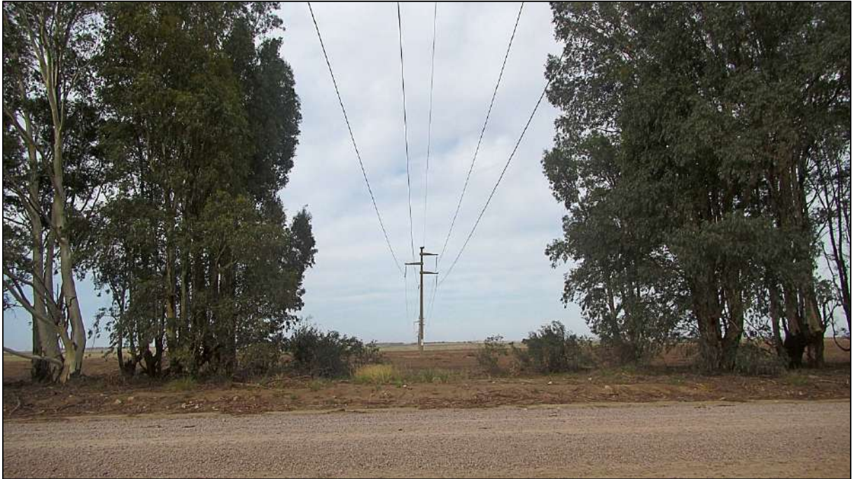
Sitio 7 (38,60339°S 61,96709°O). Alternativa 1 (verde). Vista de la traza hacia la ET Bahía Blanca, paralela a la LAT 132 kV La Genoveva-Bahía Blanca, en predio de Cooperativas Argentina – Criadero de Cereales. Será necesario ampliar el paso a través de la cortina de eucaliptus para permitir el paso de la Alternativa 1.
