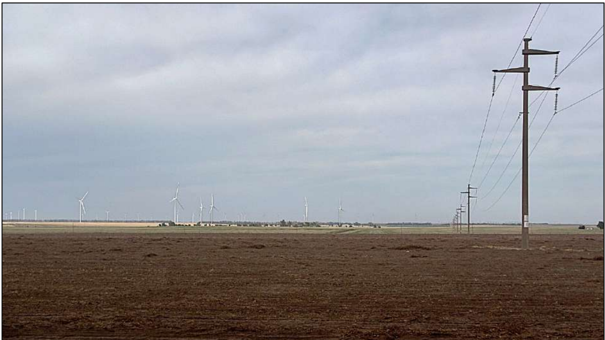
Sitio 7 (38,60339°S 61,96709°O). Alternativa 1 (verde). Vista de la traza hacia la ET Bahía Blanca a campo traviesa, paralela a la LAT 132 kV La Genoveva-Bahía Blanca, en predio de Cooperativas Argentina – Criadero de Cereales.
