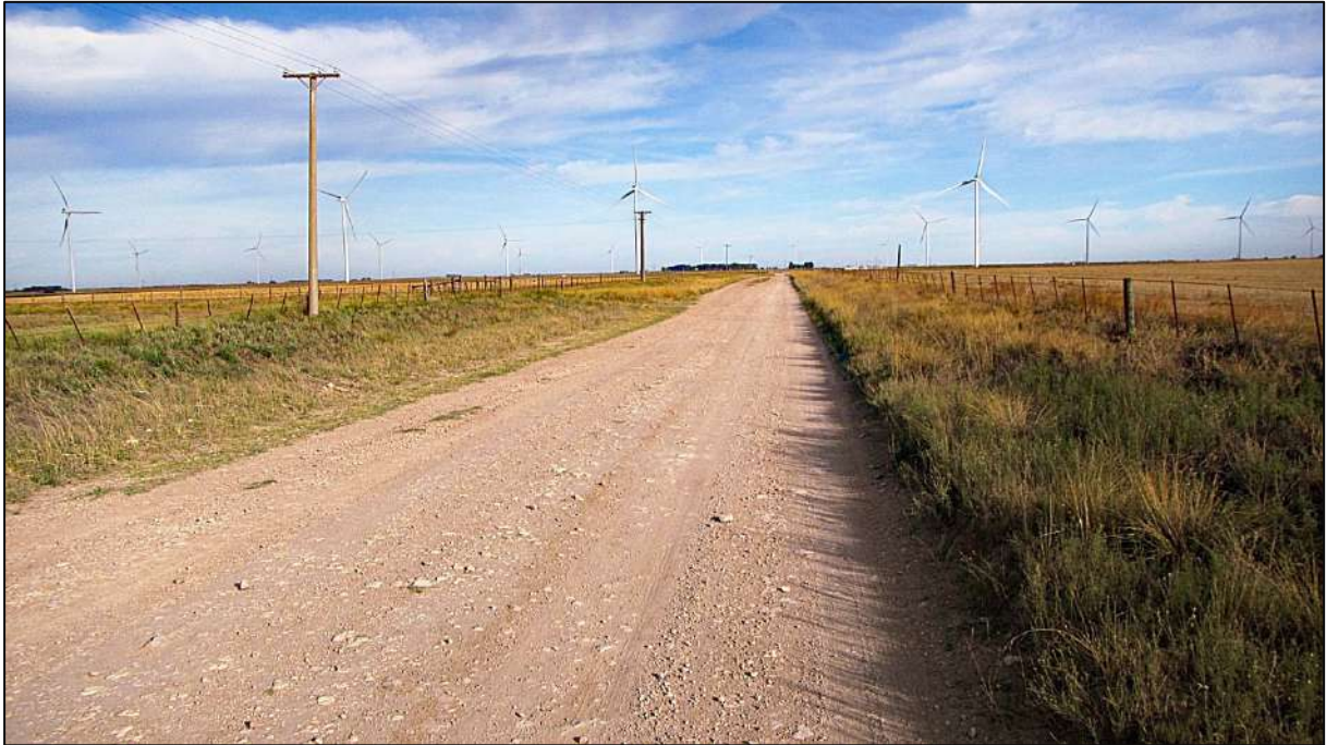
Sitio 0 (38,58398°S 61,91028°O). Inicio de la traza de ambas alternativas, Alternativa 1 (verde) y Alternativa 2 (roja) en la ET Napostá Chico del Parque Eólico Los Alamitos. Vista del camino rural (no pavimentado) hacia la Ruta Provincial 51. Sobre el fondo, aerogeneradores del Parque Eólico La Genoveva.
