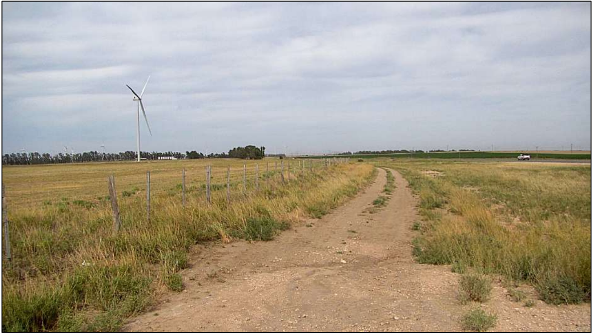
Sitio 17 (38,63702°S 62,00624°O). Alternativa 2 (roja). La traza transcurre por zona de camino de la Ruta Provincial 51. Vista hacia la ET Bahía Blanca.
