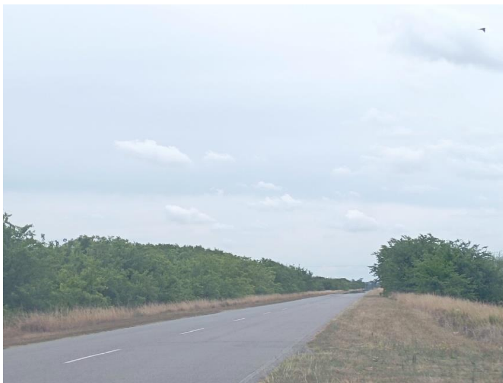
Figura 15 – Vista Camino Camino Secundario 093-05 a la altura del PSF Polvaredas
