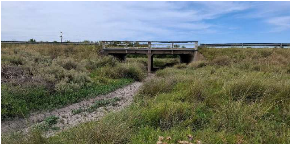
Fotografía 22. Cruce de arroyo sobre la ruta 3,1km al este de la planta de TGS.
