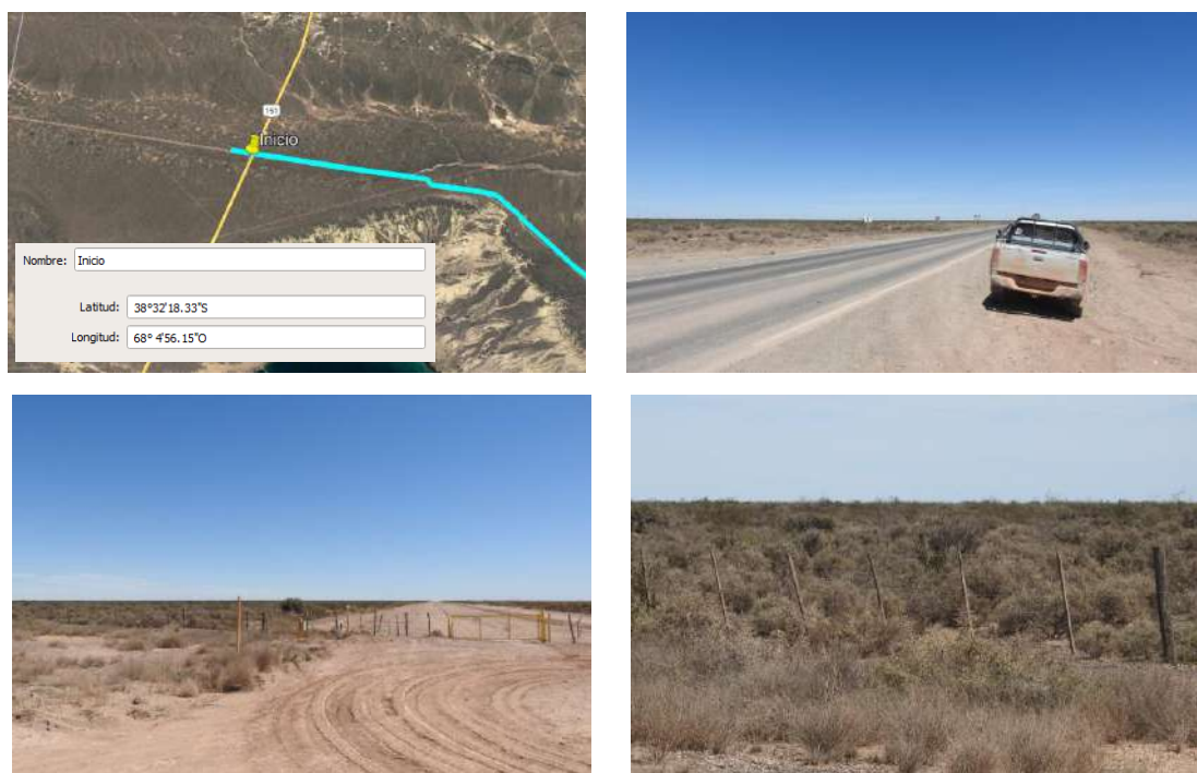
Figura 7. Sitio de inicio del poliducto fotografías ilustrativas. Fuente: elaboración propia.
