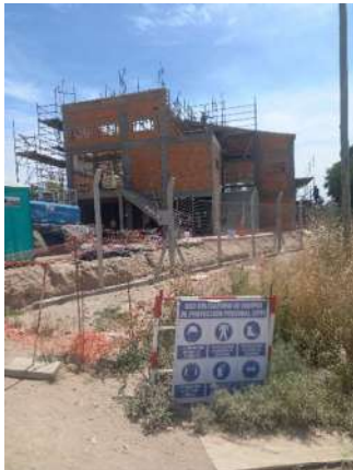
ET Cangrejales (en construcción)
