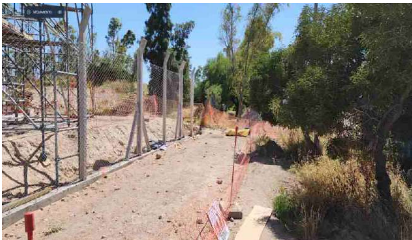
F1: Fotografía 1. Estación Transformadora Cangrejales -en construcción, 26.12.2025-
