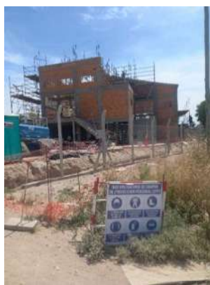
ET Cangrejales (en construcción)
