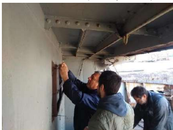
Colocación de placas protegidas, disposición vertical
