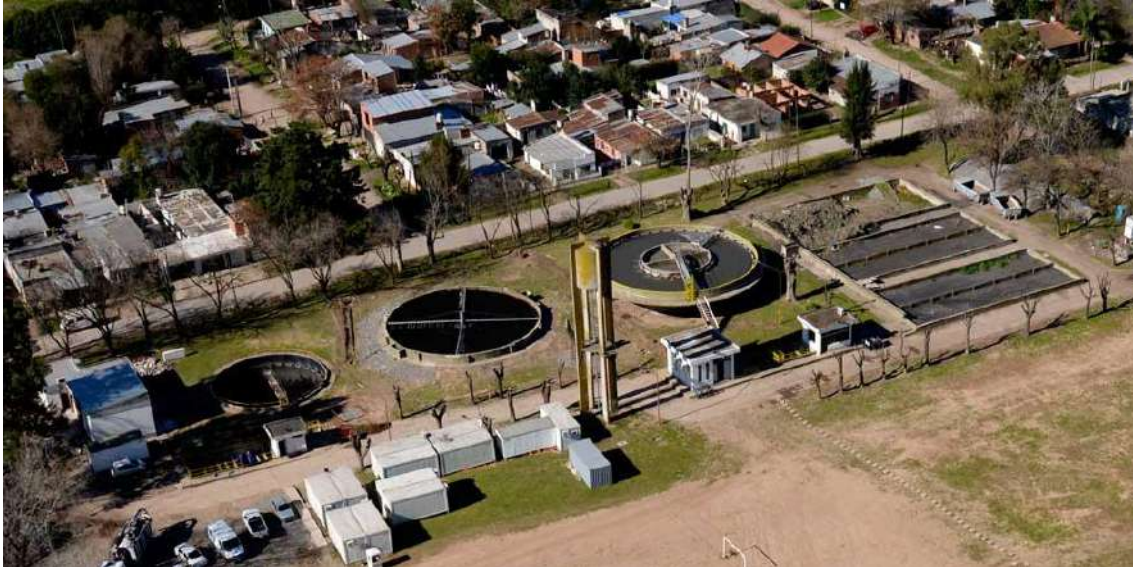
Foto aérea de la Planta Depuradora Escobar – AySA S.A.
