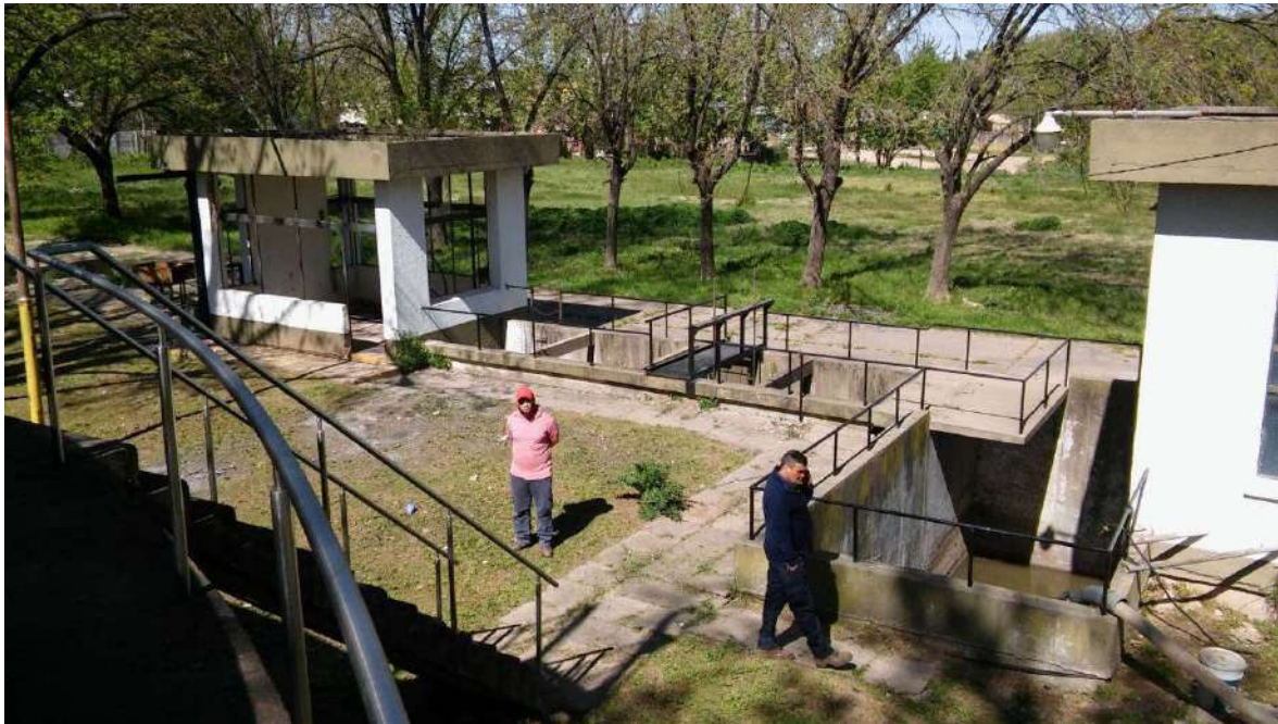
Foto 13: Estación de Bombeo y Desarenador
