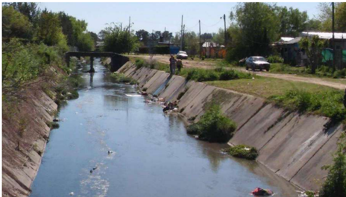
Foto 15: Cuerpo Receptor de Efluentes de Planta Depuradora
