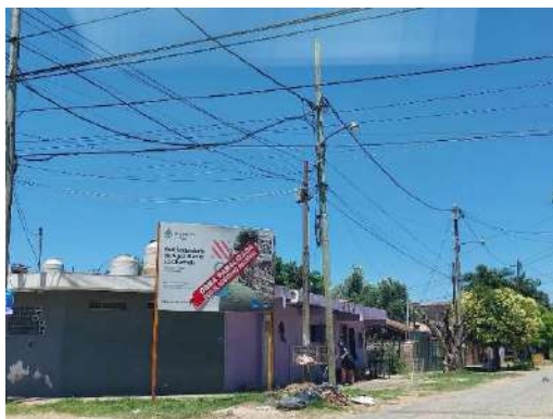
Foto 41: cartel de obra en calles Tucumán y Belén, con aviso de suspensión de las mismas.
