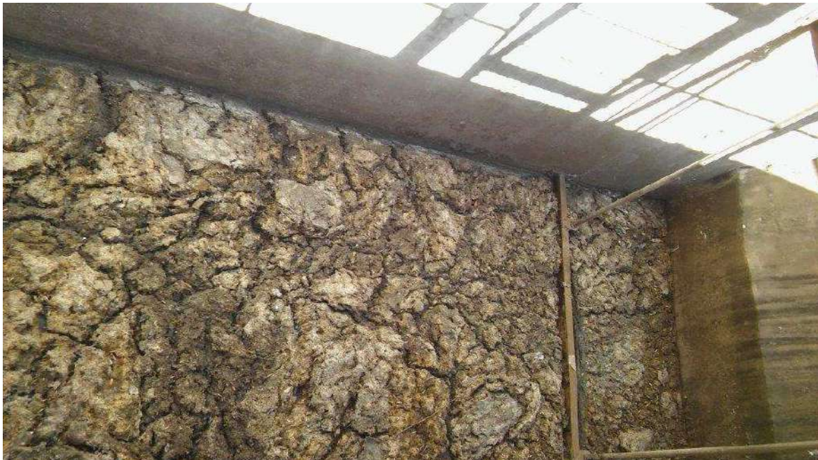
Foto 14: Barros Acumulados en Desarenador. (Presencia de Olores por descomposición anaeróbica)
