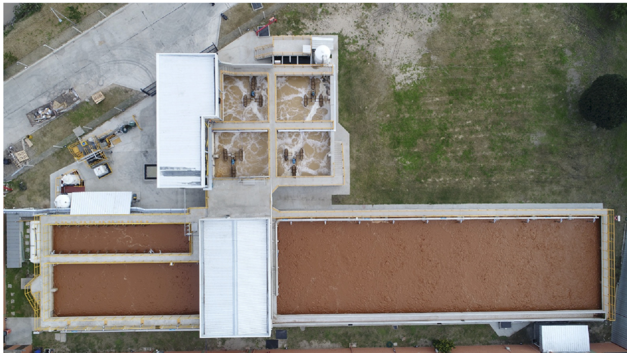
Ilustración 2: Vista aérea de la planta de tratamiento de efluentes industriales y cloacales
