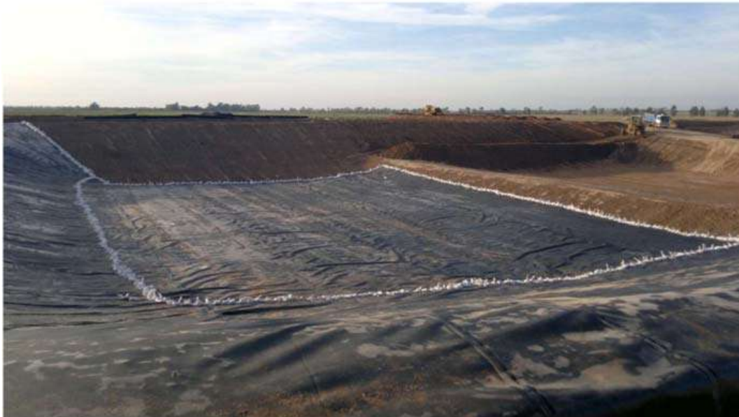
Imagen 4. Vista de referencia de la instalación de la membrana. Fuente. Municipalidad de Tandil
