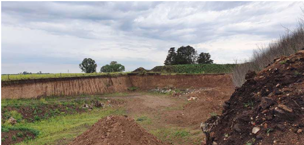
Imagen 6. Fosa para relleno donde se puede observar el perfil de suelo del área del proyecto.
