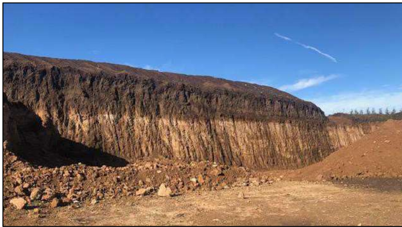
Fotografía 8.7. Vista de interior de cava con presencia de limo-arenoso con intercalaciones de tosca y suelo orgánico superficial.
