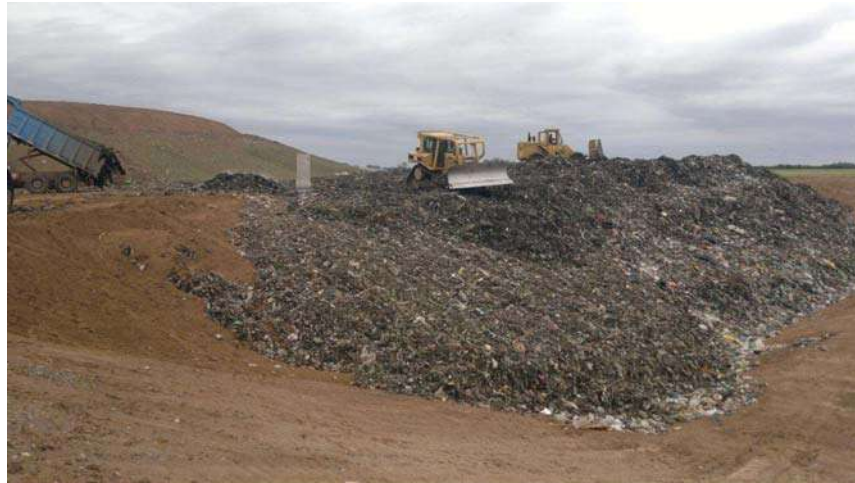
Imagen 6. Labores en relleno sanitario. Fuente. Municipalidad de Tandil
