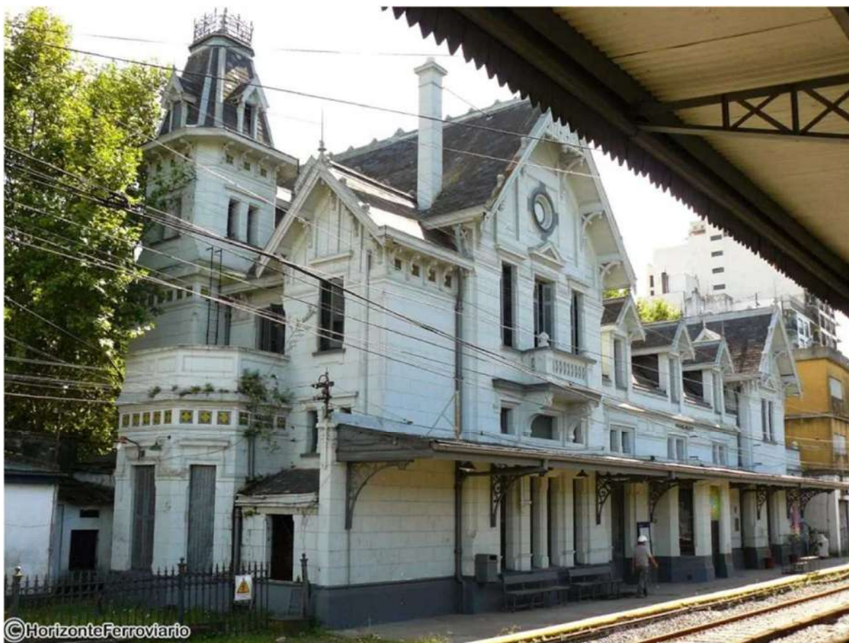
Fotografía 14. Antigua edificio de la estación Ramos Mejía. Fuente: Horizonte Ferroviario
