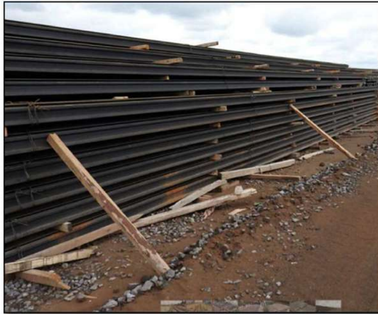
Fotografía 2. Rieles de 18 metros R260
