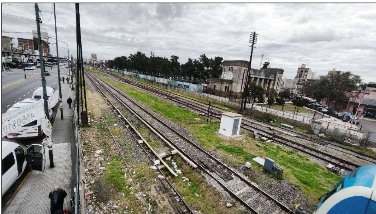
Fotografía 12. Sector de vías en el cruce con Av. General Paz, con algunos residuos dispersos
