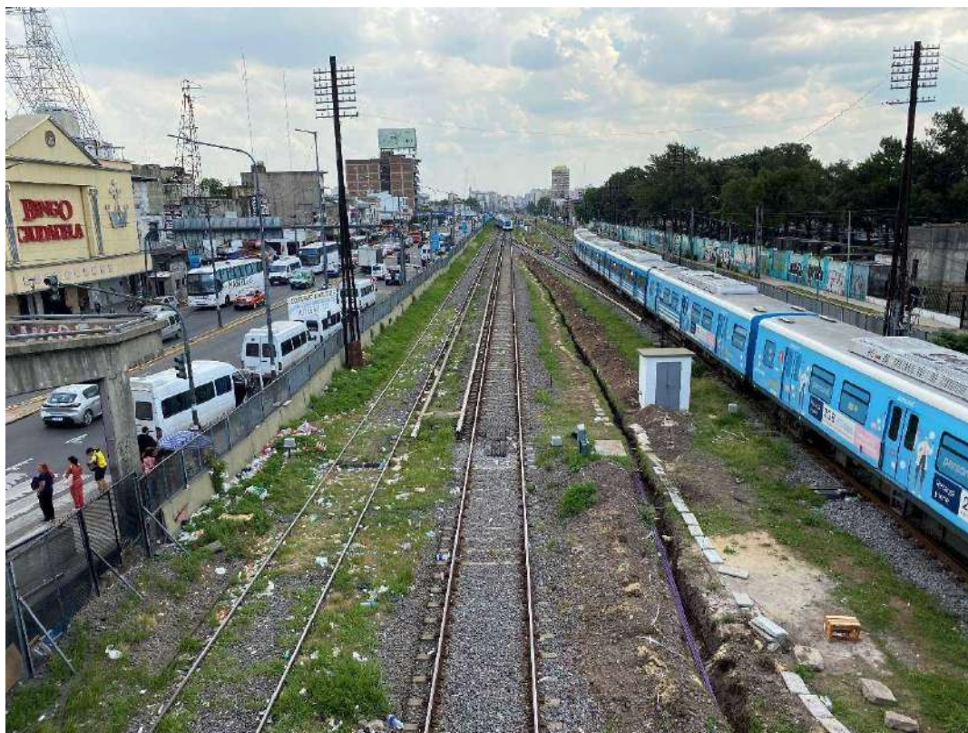
Fotografía 13. Zona de vías con algunos residuos acumulados, Ciudadela
