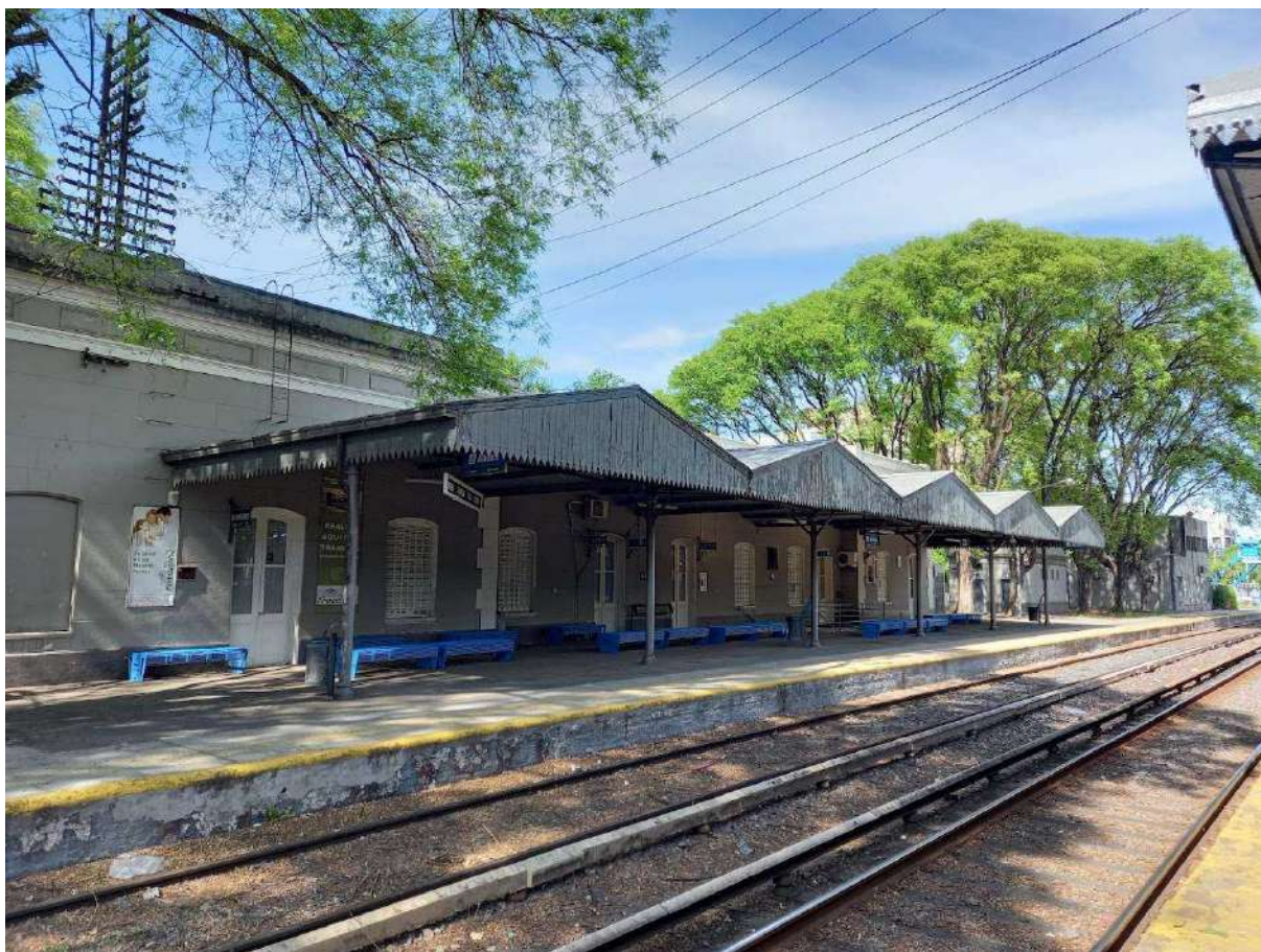
Fotografía 16. Edificio Estación Haedo
