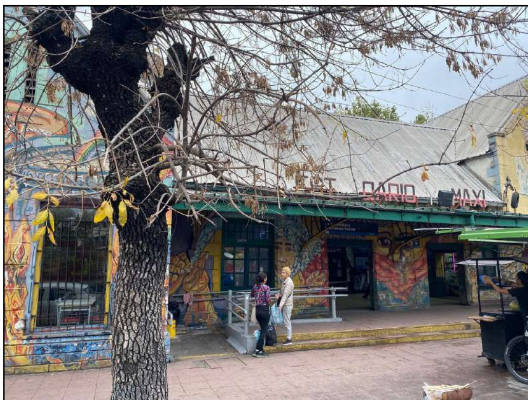
Fotografía 14. Fachada estación Avellaneda
