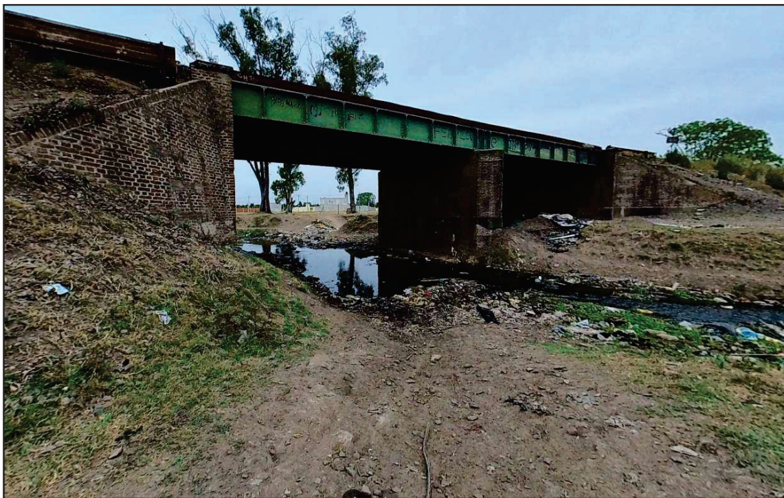
Fotografía 14. Intersección Arroyo Pinazo y puente ferroviario de la LSM
