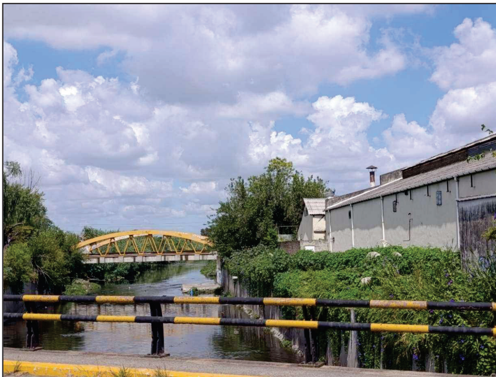
Fotografía 9. Arroyo Morón desde la RP N° 201 hacia el sur
