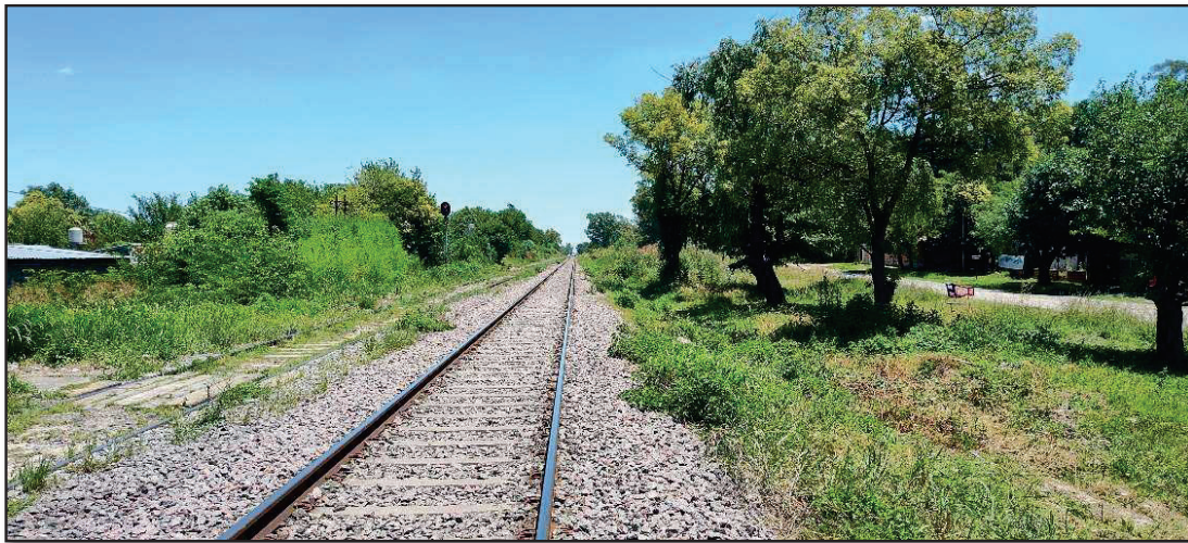
Fotografía 1. Parte de tramo a renovar en Oro Verde
