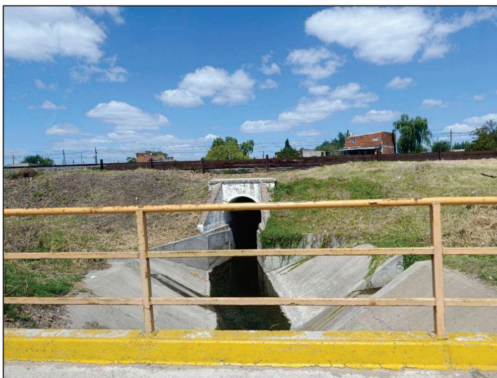
Fotografía 13. Cruce del canal con la traza del FCGSM, vista hacia el Sur
