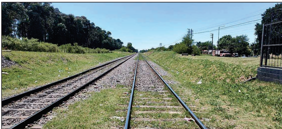
Fotografía 2. Parte de tramo a renovar en Pilar
