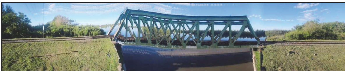
Fotografía 11. Río Reconquista desde el puente Ferroviario del FCGSM
