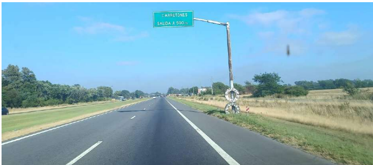
Figura 3.18 Acceso desde el sur por RN 9. El cartel indica la salida para acceder al área industrial de Zarate. El entorno es rural.
