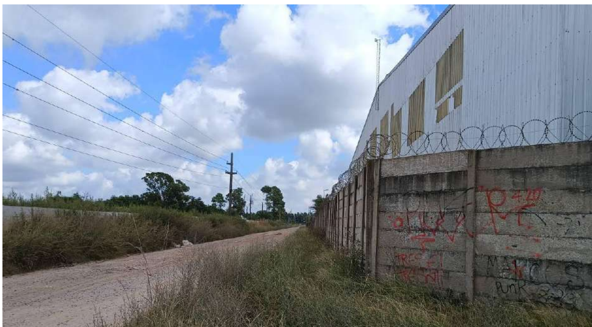
Figura 3.74 Recorrido por calle 42 en área industrial.
