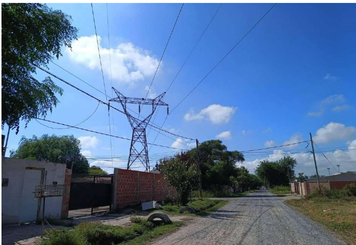
Figura 3.32 Paso de la LAT ILSZA1 sobre la zona de servidumbre invadida por el desarrollo suburbano.
