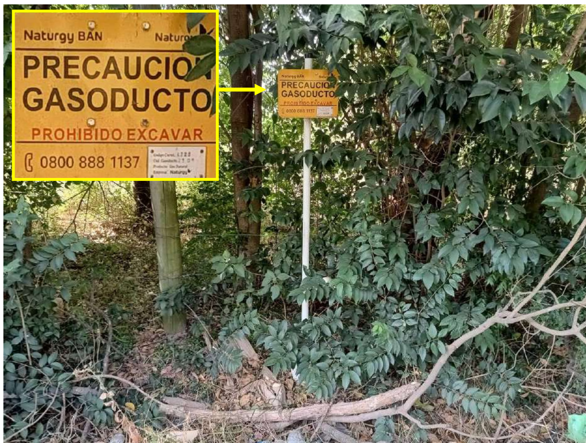
Figura 3.24 Señalización de gasoducto de la empresa Naturgy, con indicación de prohibición de excavación, a 200 m del Piquete 11N (PAI-2).
