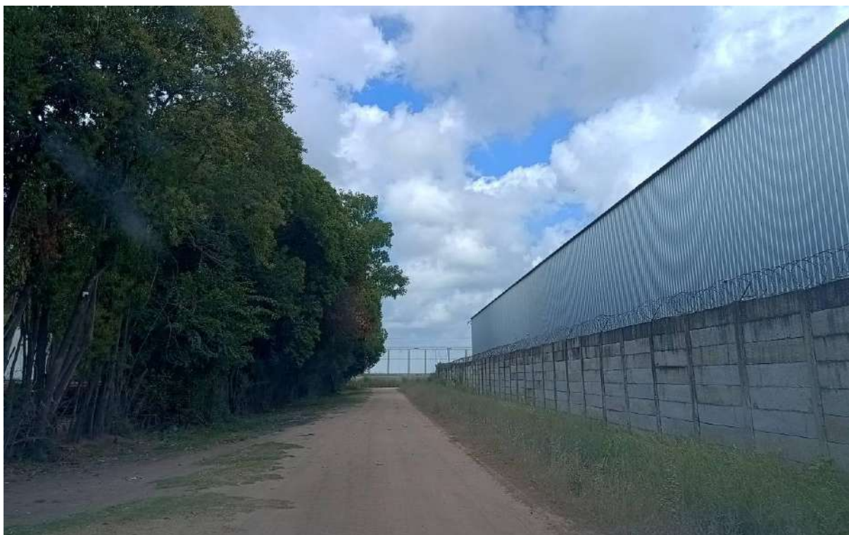
Figura 3.73 Tramo final por calle 1, con presencia de arbolado sobre uno de los laterales.
