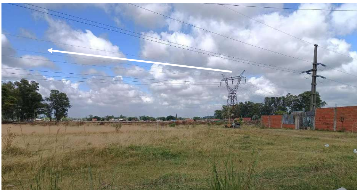
Figura 3.34 Vista desde la calle 34 de tramo de la LAT 1LSZA1 en área en crecimiento.
