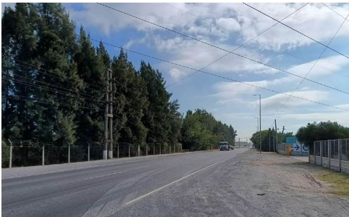
Figura 3.38 Tramo por camino de acceso industrial.
