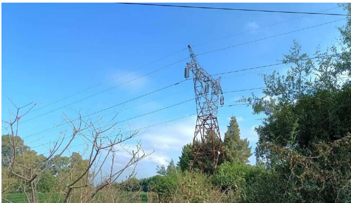
Figura 3.27 Torre 11N de la LAT ILSZA1, terminal de una de las trazas nuevas. El terreno lindante no presenta construcciones.
