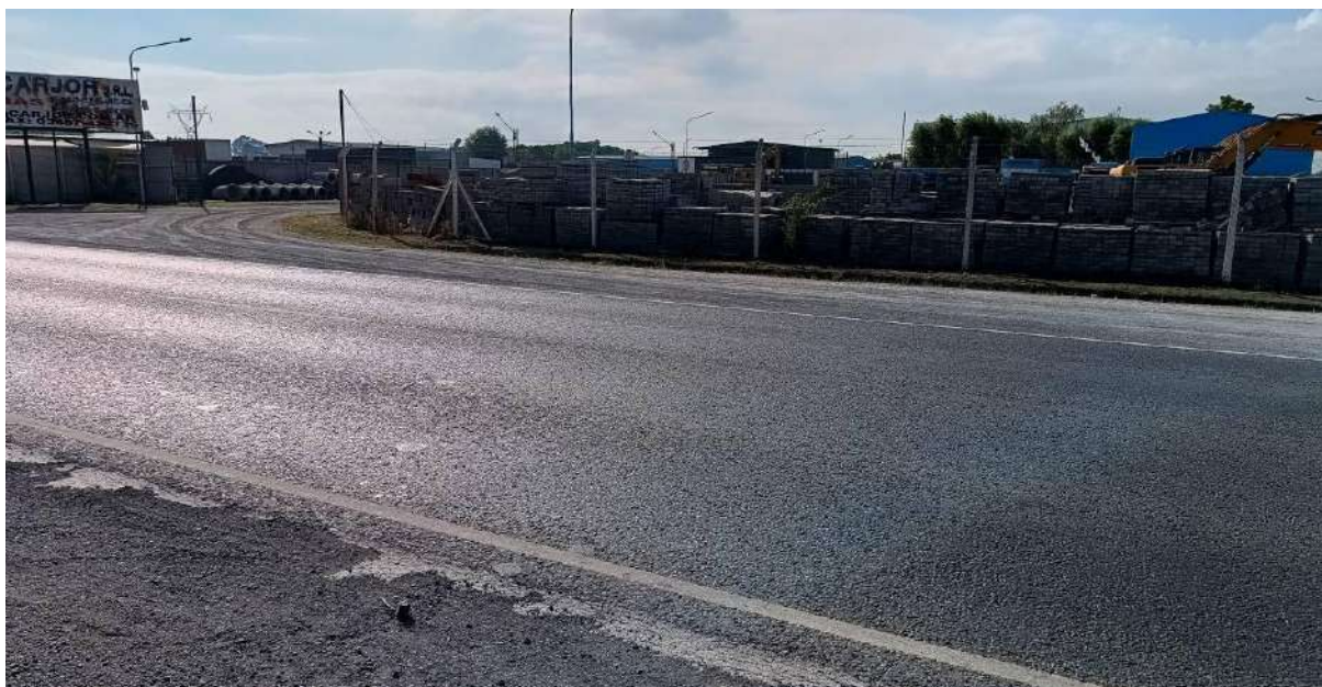
Figura 3.37 Area del camino de acceso industrial donde se instalará el PAI-2 terminal del soterramiento 1LSZA1.
