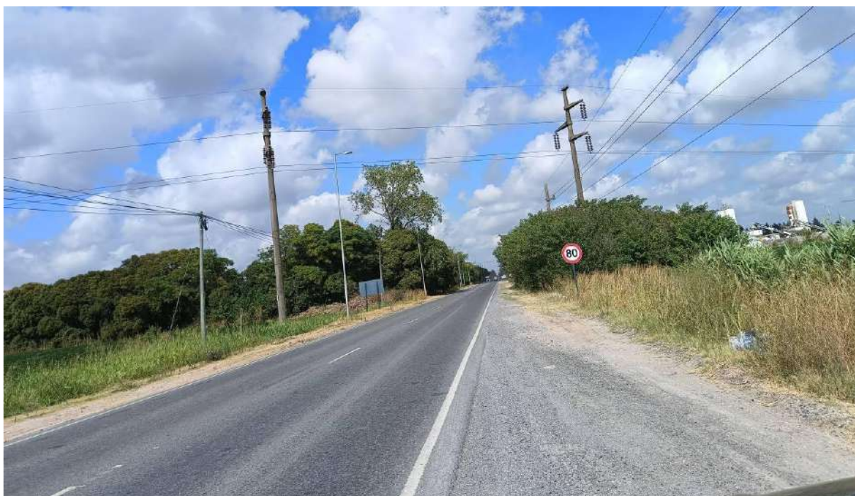
Figura 3.77 Fin del recorrido en el cruce de la LAT existente en el camino de la Costa Brava (sitio de instalación de PAI-1).
