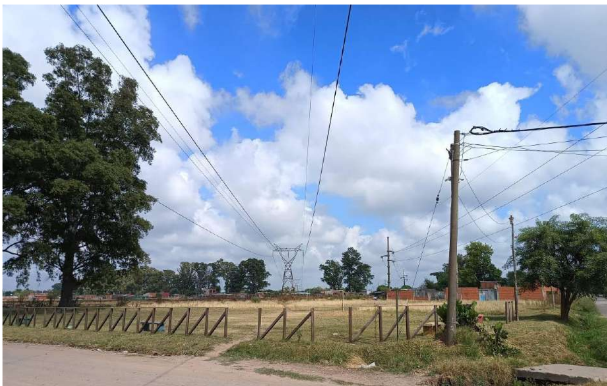
Figura 3.35 Paso de la LAT ILSZA1 sobre la plaza en la esquina de calle 34 y Valentin Alsina.
