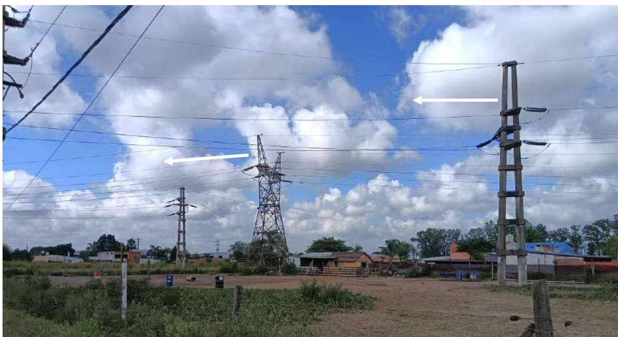
Figura 3.36 Llegada de ambas LAT a los últimos piquetes antes de la ET Zarate. EA la derecha se ve el poste 1 de la LAT IATZA1, y al centro de la foto la torre 1 de la LAT ILSZA1. Debajo de ambas, zona suburbana desarrollada.
