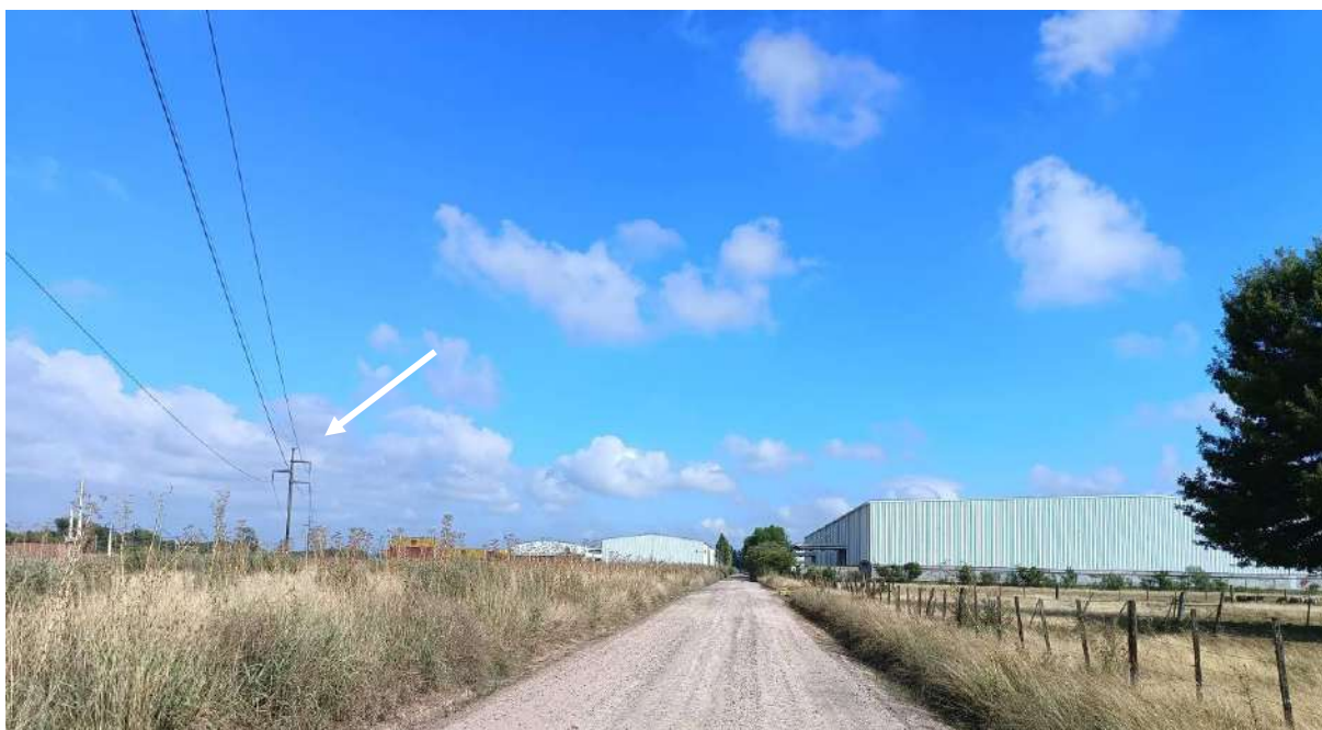
Figura 3.31 Ingreso a la zona industrial de la LAT IATZA1. Se observa el Poste 12.
