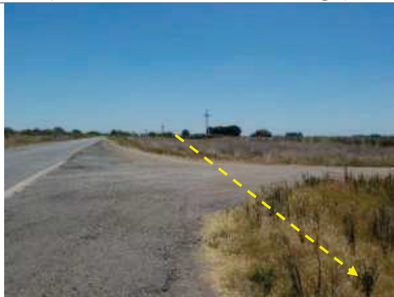
Foto 3.6-61. Pk 35442. Vista al NNO. Traza por margen de RP 30, cruce con camino de acceso (35° 14'47.75"Lat.S; 59° 42'5.61"Long.O).
