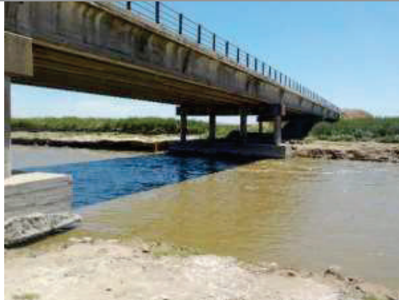
Foto 3.6-57. Pk 32299. Cruce del Río Salado (35° 13'21.70"Lat.S 59° 43'4.83"Long.O).
