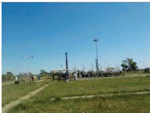
Foto 3.6-36. Planta de Almacenamiento y Vaporización de GLP Moquehuá perteneciente a BAGSA dentro de la cual se emplazará la ERP.
