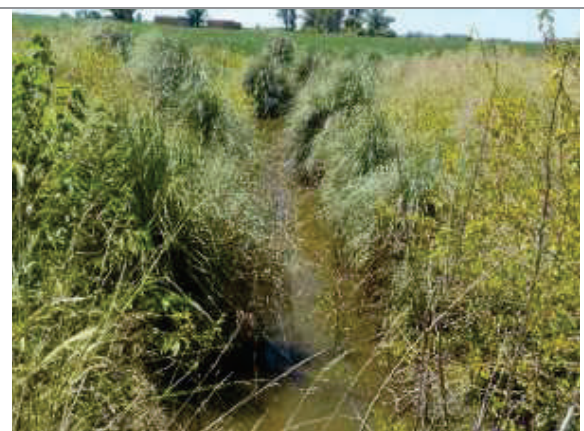
Foto 3.6-50. Pk 21600. Cruce de arroyo sobre la Ruta Provincial N° 30 (35° 6' 31.05" Lat. S 59° 44' 49.59" Long. O).
