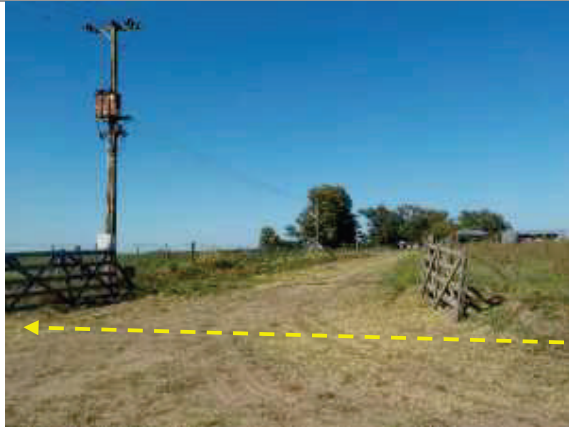
Foto 3.6-19. Pk 12.000. Vista al Sur. Cruce de acceso a establecimiento rural con tranquera ( 35^{\circ} 3'19.90'' Lat. S; 59^{\circ} 48'58.52'' Long. O).
