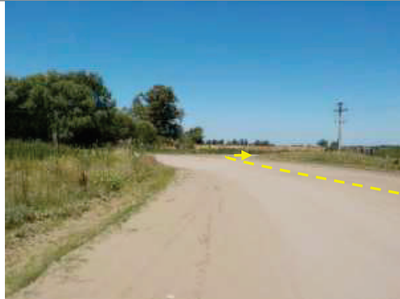
Foto 3.6-78. Vista al SO del quiebre que hace la traza para tomar camino perimetral con dirección NO.
