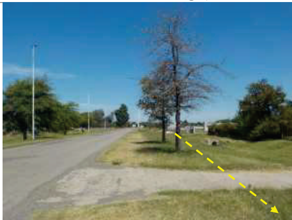
Foto 3.6-41. Vista al O. Pk 19.695. Trazas cruzan el acceso a la Subestación de Rebaje Moquehuá de EDEN.
