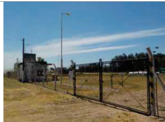
Foto 3.6-81. Planta de GLP donde se emplazará la nueva ERP N. de la Riestra.
