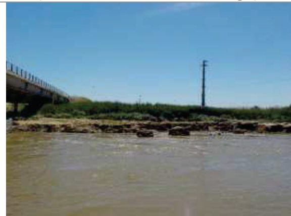
Foto 3.6-60. Pk 32299. Cruce del Río Salado (35° 13'21.70"Lat.S 59° 43'4.83"Long.O).
