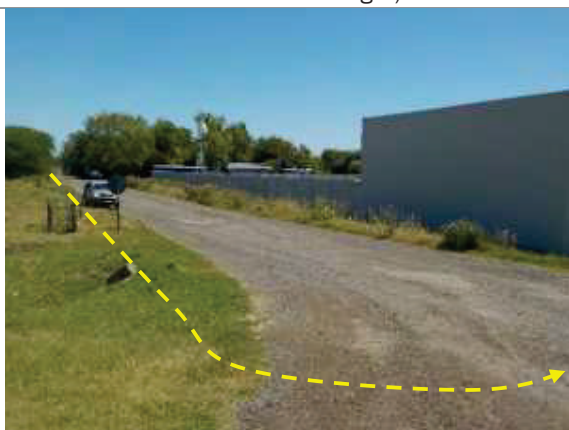
Foto 3.6-39. Vista al NO. Trazas desarrollándose por calle Chacabuco antes de virar al E (35° 5'36.75"Lat. S 59° 45'56.48"Long.O).
