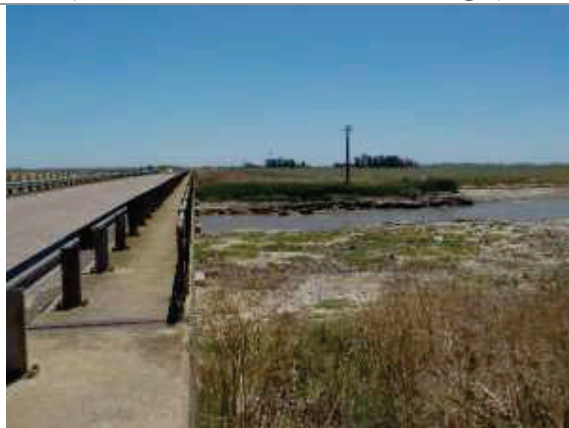
Foto 3.6-59. Pk 32299. Cruce del Río Salado (35° 13'21.70"Lat.S 59° 43'4.83"Long.O).
