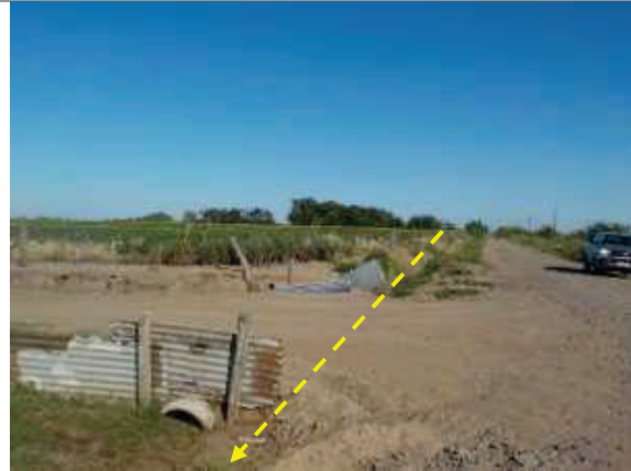
Foto 3.6-14. Pk 6.425. Vista al NO. Camino de acceso a establecimiento rural con alcantarilla (35° 1'10.15" Lat.S; 59° 51'33.12" Long.O).
