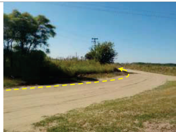
Foto 3.6-22. Pk 15.400. Vista al SO. La traza gira nuevamente para tomar dirección SE.
