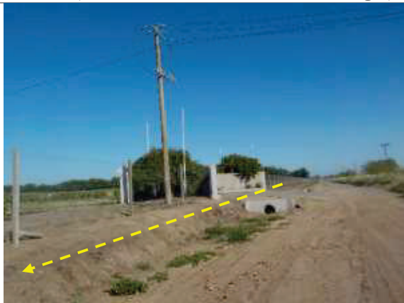
Foto 3.6-17. Pk 7.325. Vista al NO. Cruce de entrada a Establecimiento KWS Argentina (proveedor de semillas) con alcantarilla (35° 1'30.93" Lat. S; 59° 51'8.16" Long. O).
