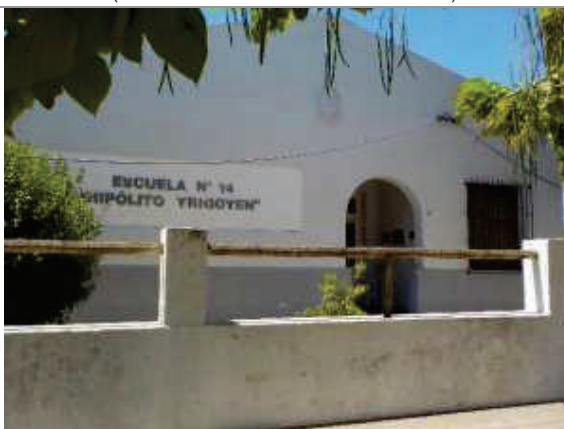
Foto 3.6-71. Escuela sobre la calle 2 de Abril.
