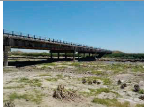
Foto 3.6-58. Pk 32299. Cruce del Río Salado (35° 13'21.70"Lat.S 59° 43'4.83"Long.O).
