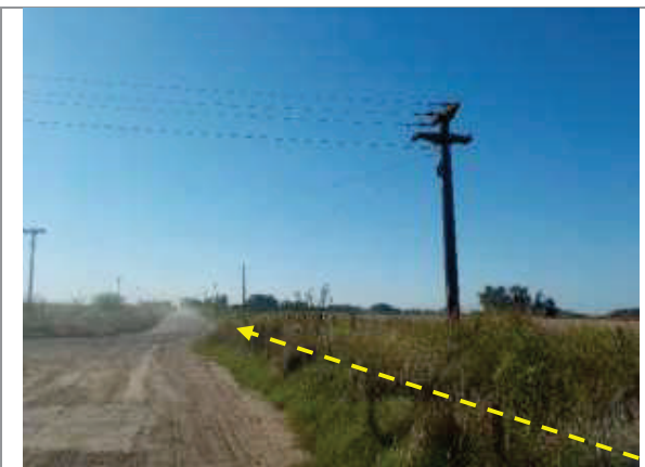
Foto 3.6-11. Pk 4.550. Vista al SE. Traza por margen de camino. Cruce de línea eléctrica ( 35^{\circ}0'27.19'' Lat.S; 59^{\circ}52'23.67'' Long. O).
