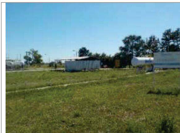
Foto 3.6-35. Planta de Almacenamiento y Vaporización de GLP Moquehuá perteneciente a BAGSA dentro de la cual se emplazará la ERP.
