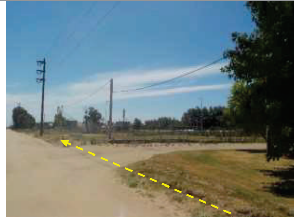
Foto 3.6-79. Vista al NO. Cruce con calle Los Paraísos.
