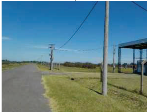
Foto 3.6-48. Vista al SO. Garita de entrada a Parque Industrial de Moquehuá "Domingo Falabella". Fin del tramo (35° 5'34.89"Lat.S; 59° 44'38.46"Long.O).
