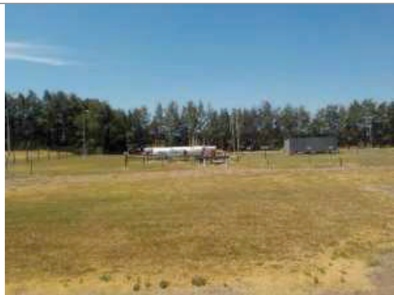
3.6-82. Planta de GLP donde se emplazará la nueva ERP N. de la Riestra.
