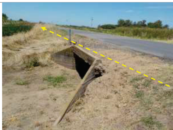
Foto 3.6-53. Vista al S. Alcantarilla en margen de RP 30 (35° 7'35.29" Lat. S; 59° 44'44.25" Long. O).
