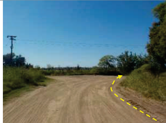
Foto 3.6-20. Pk 15.000. Vista al SE. La traza cambia de sentido de SE a SO ( 35^{\circ} 4'25.33'' Lat. S; 59^{\circ} 47'33.35'' Long. O).
