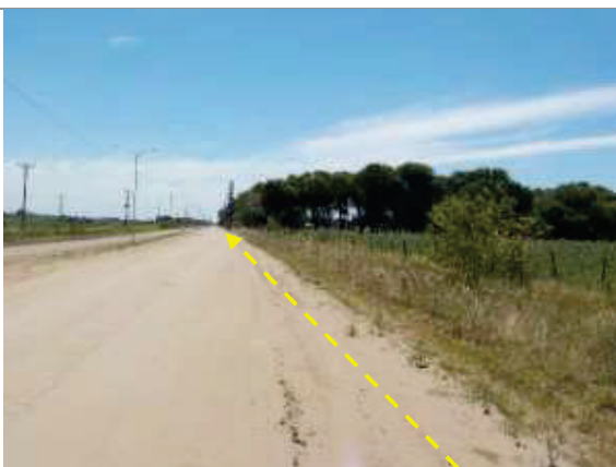
Foto 3.6-77. Vista al NO. Traza vira al NO dejando la calle Leopoldo Acuña y tomando una calle perimetral del pueblo (35° 17' 7.95" S 59° 46' 12.79" O).
