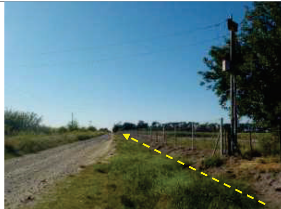
Foto 3.6-16. Pk 7.095. Vista al SE. Cruce de línea eléctrica.
