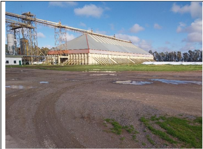
Celda (se divide en dos, de 30000 y 15000 tn c/u) y cinta transportadora
