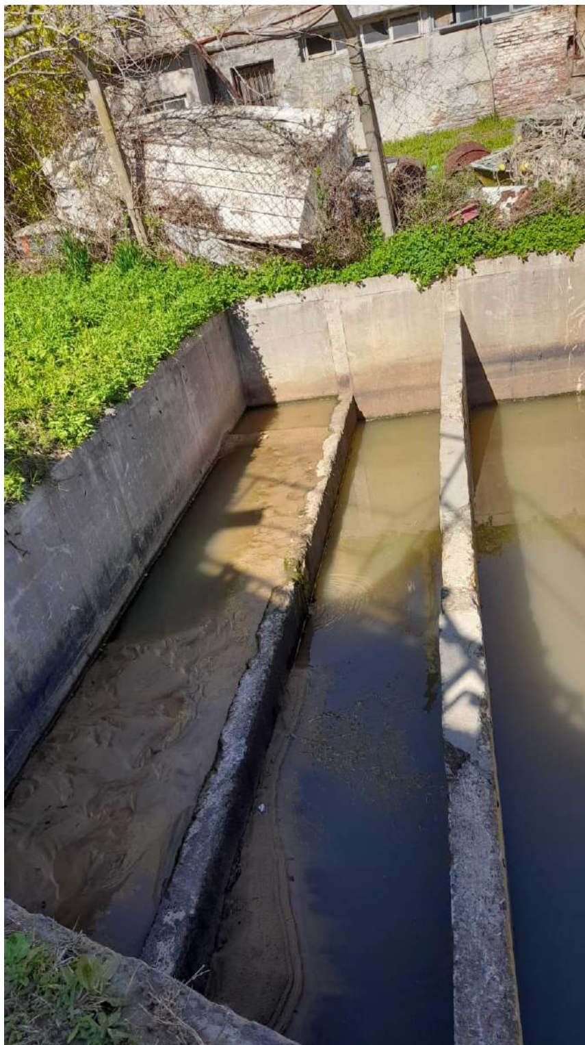
Imagen correspondiente a una de las decantadoras
