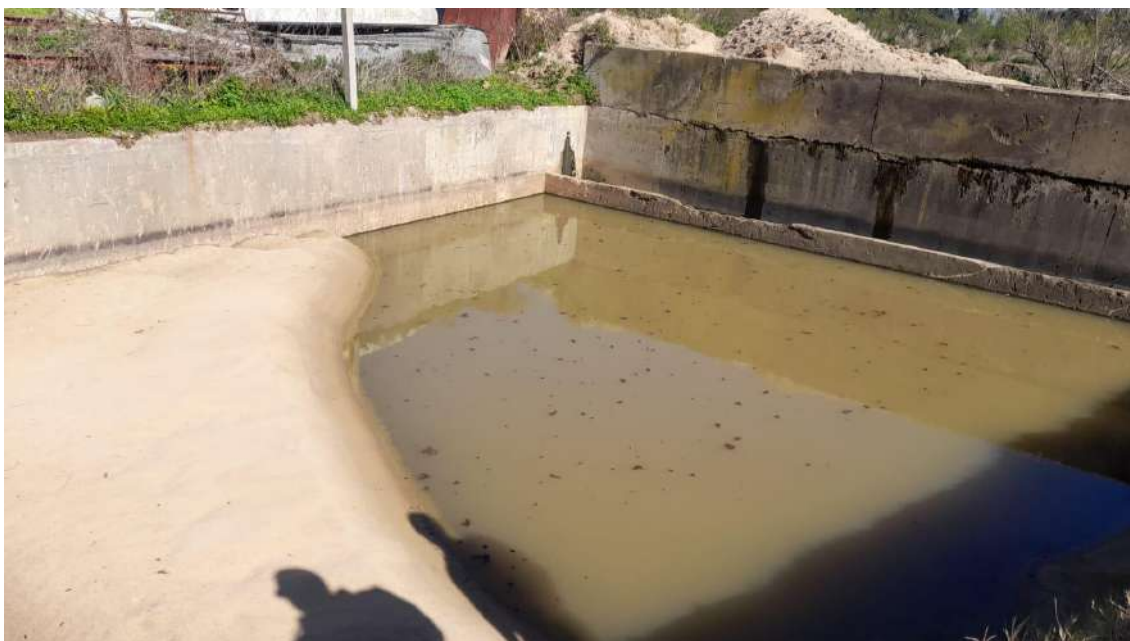
Imagen correspondiente a una de las decantadoras
