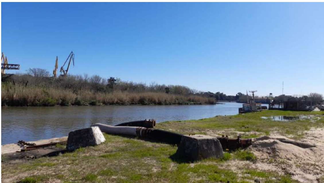
Imagen correspondiente a la cañería de descarga que extrae la arena desde los barcos
