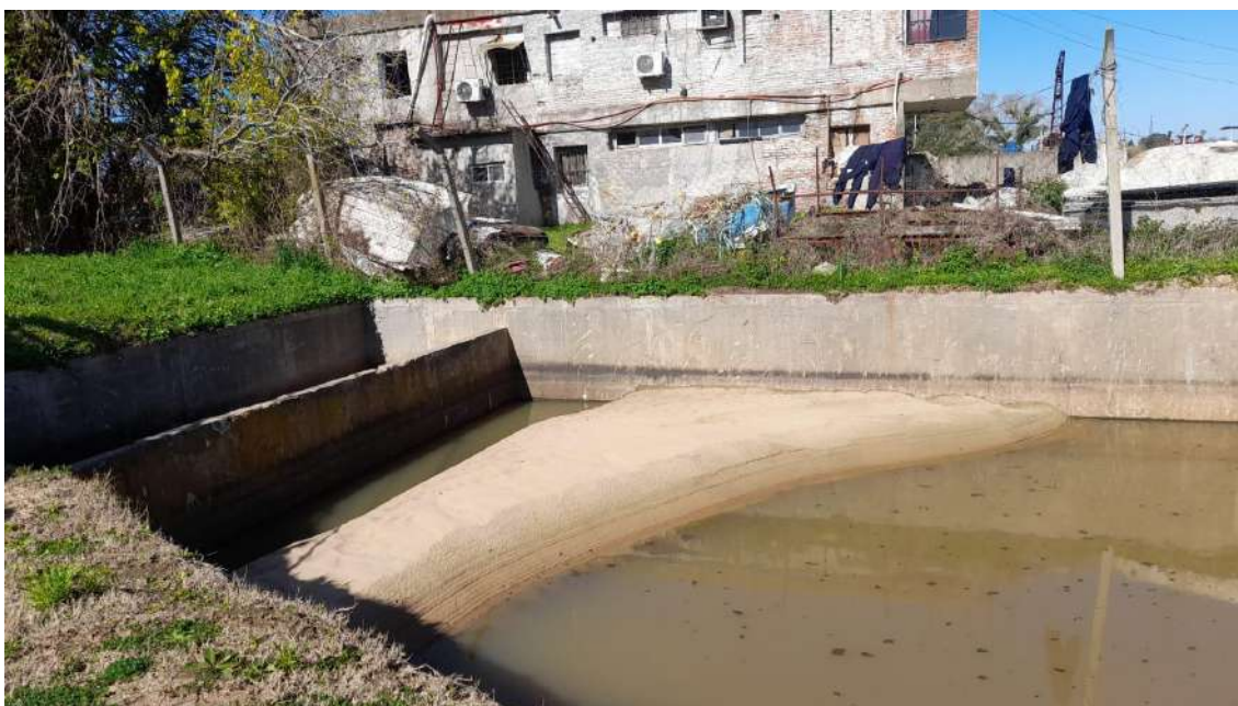
Imagen correspondiente a una de las decantadoras
