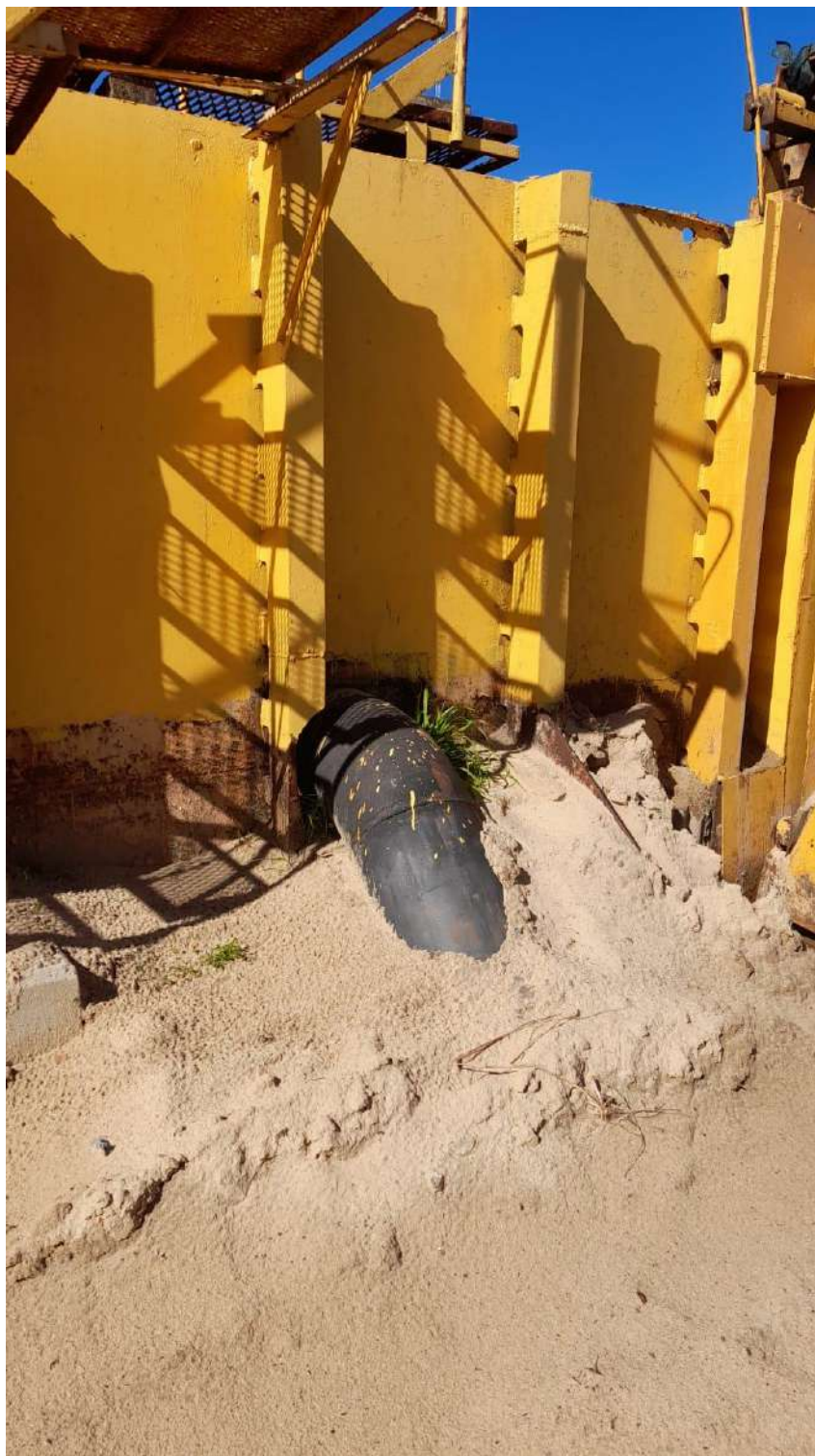
Imagen correspondiente a una de los caños utilizadas en las piletas
