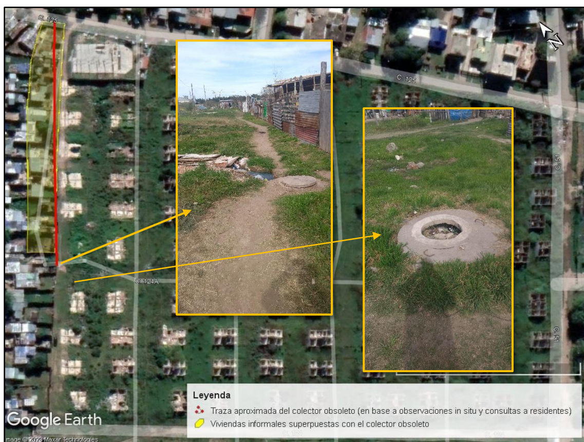
Figura 4: Viviendas construidas sobre un colector obsoleto en las ruinas del Barrio Kennedy Norte.
