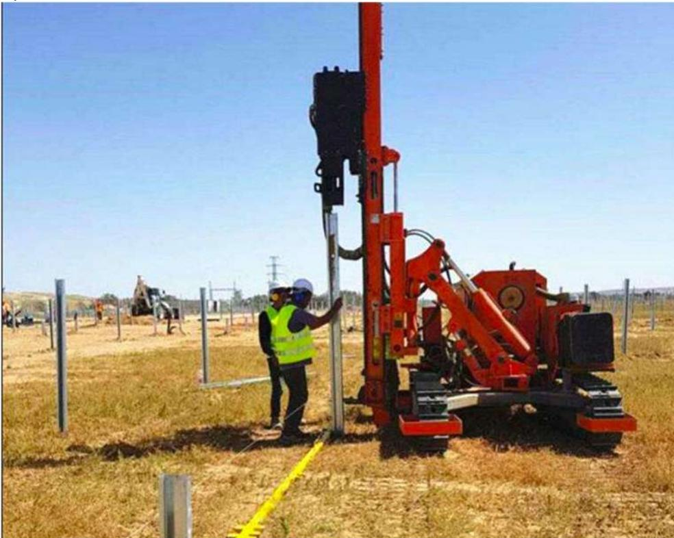
Imagen 20 Ejemplo de hincadora de perfiles para estructuras de paneles. Fuente: <http://www.iderosolar.com.ar>
