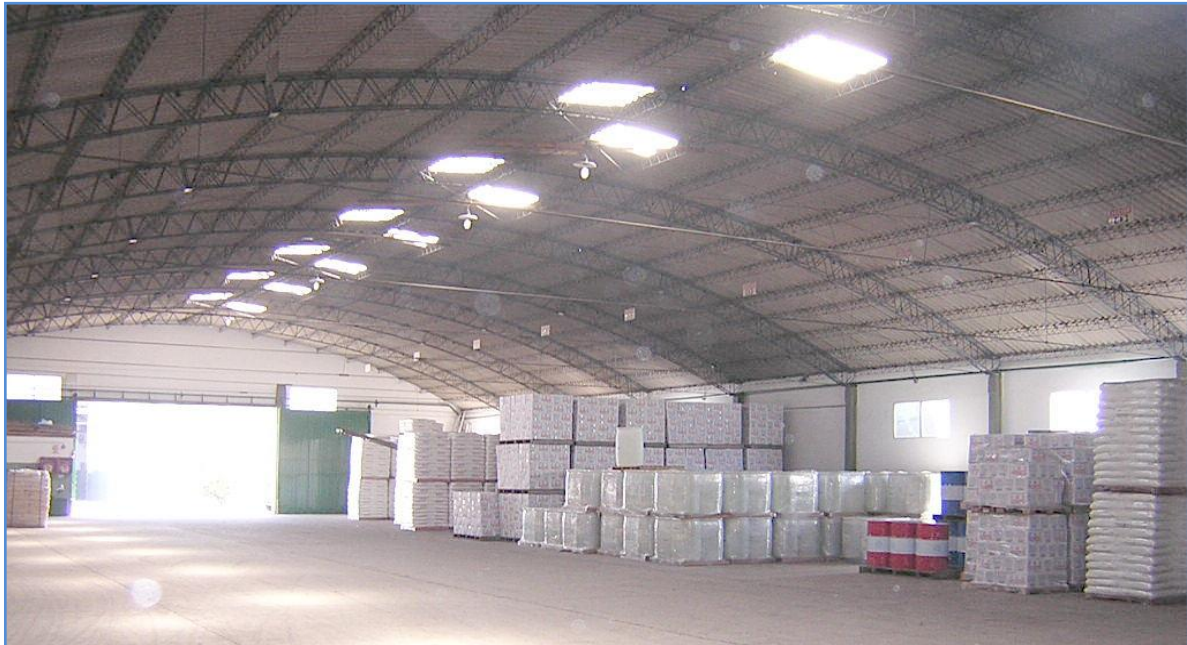
DEPÓSITO PRODUCTO TERMINADO (Se aprecia iluminación artificial)
