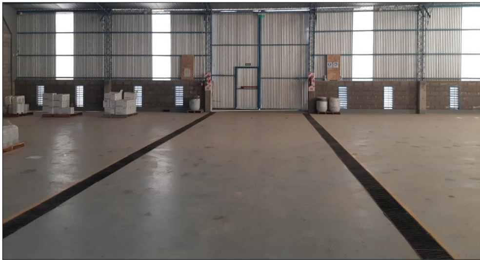
Imagen 48: Interior del Depósito.
