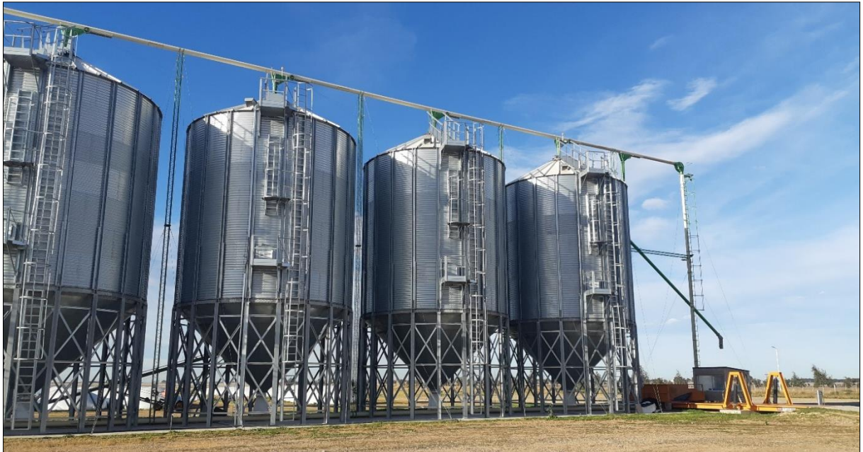
Imagen 44: Zona de carga y descarga de camiones. Circuito de transporte de cadena.
