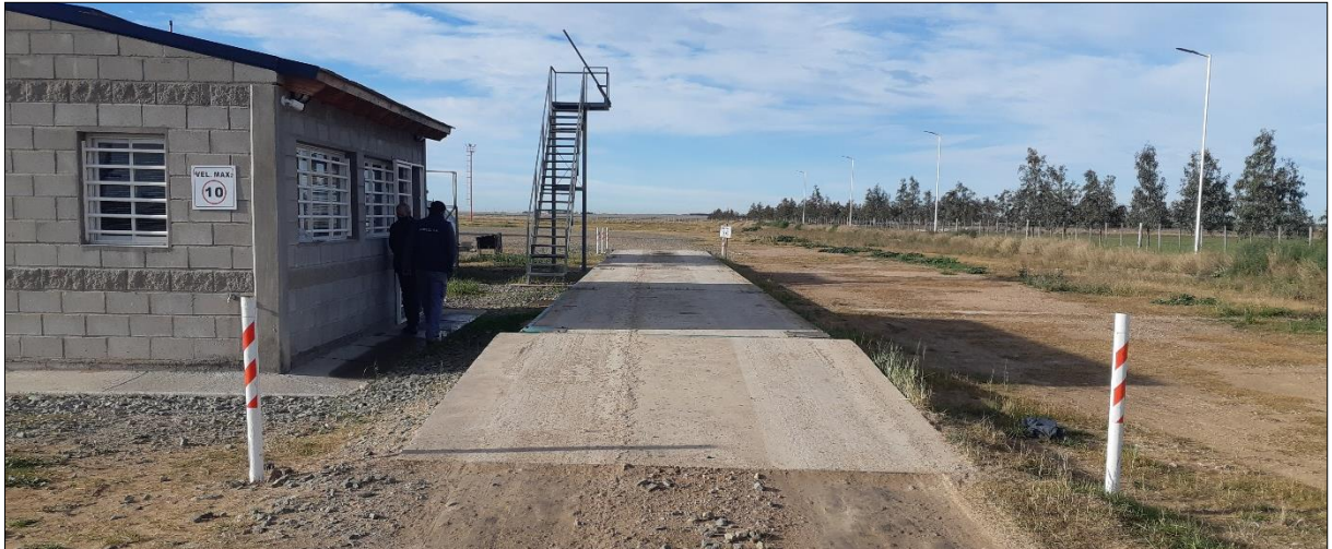
Imagen 28: Acceso de camiones hacia la balanza y posterior zona de calado.
