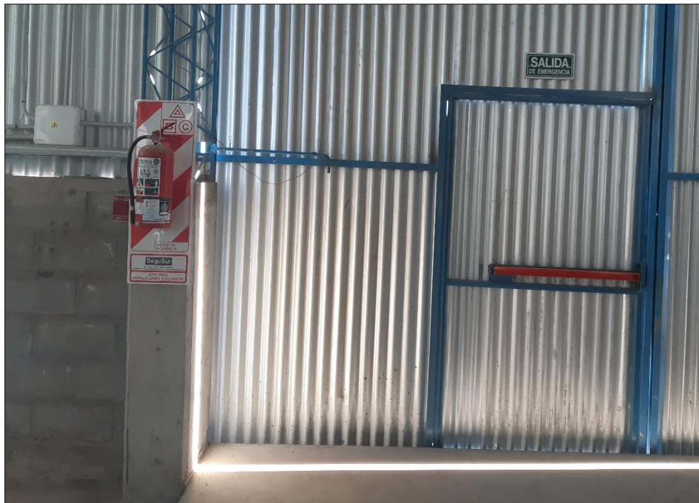
Imagen 46: Matafuego en depósito y carteles de señalización.
