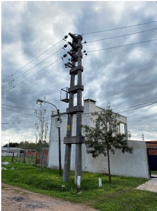
FIGURA N° 47: TENDIDO DE RED DE MEDIA TENSIÓN EN EL BARRIO ONCE
