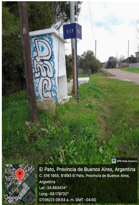
FIGURA N° 51: POZO DE AGUA NUEVOS ,FORMA PARTE DE LA RED DE EXTRACCIÓN MUNICIPAL
