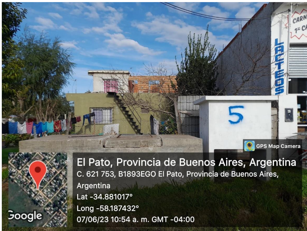
Figura N° 29: Calle 621 Pozo de agua N° 5.
