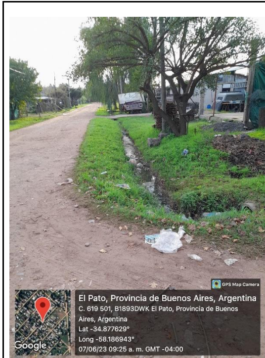
Figura N° 18: Zanjas conteniendo vuelcos sin ninguna protección
