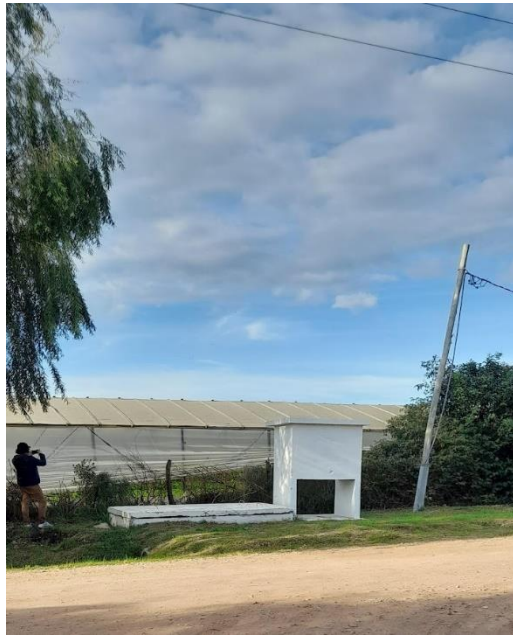
Figura N° 23: Calle 517 Y 625 Cabina pozo de agua empresa AySA.
