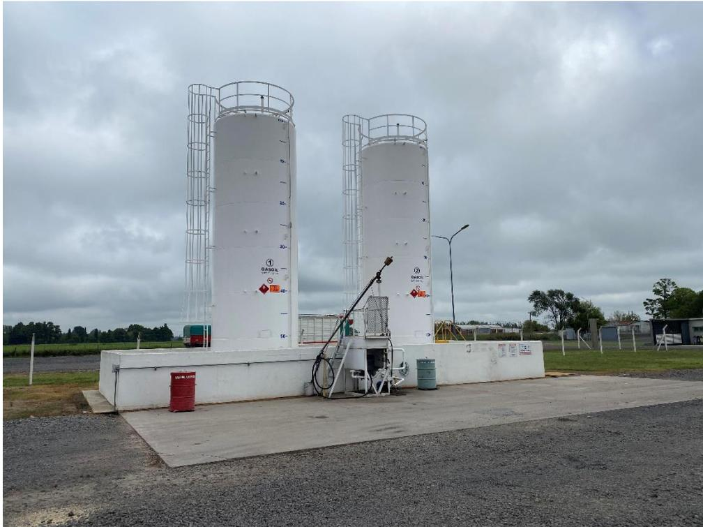
Agroservice – Tanque para almacenaje de combustible (Gas Oil), con recinto de contención y playa de carga-descarga.
