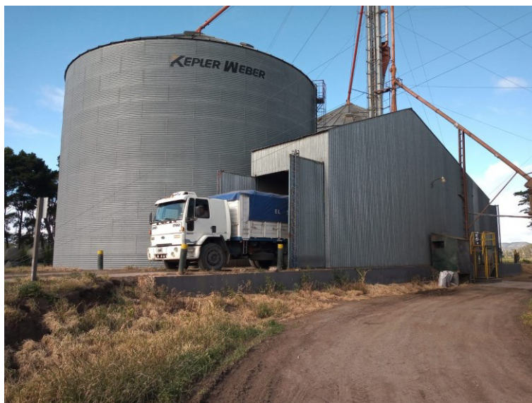
Figura: Vista del sector de carga/descarga de granos.
