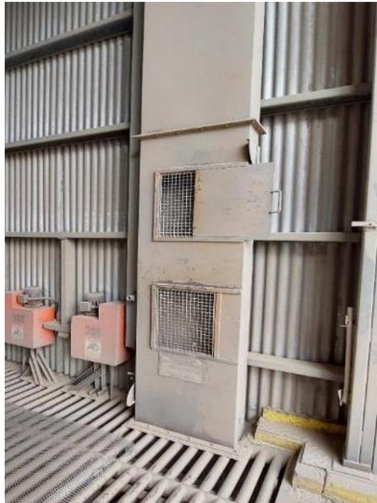
**Imagen 07. Sistema de aspiración de polvo en zona de descarga.**
