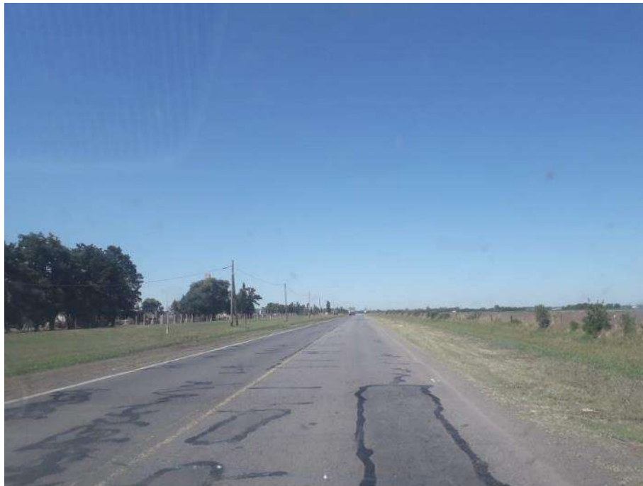
Imagen 02. Vista Ruta Provincial N° 188.
