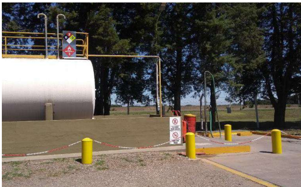
Imagen 17. Área de despacho de combustible.
