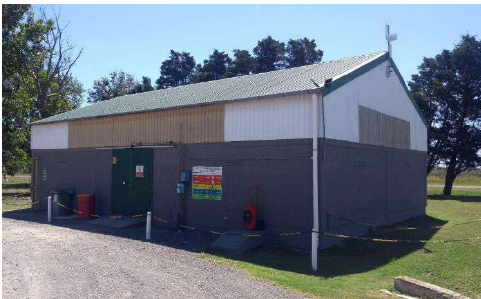
Imagen 20. Depósito de agroquímicos.
