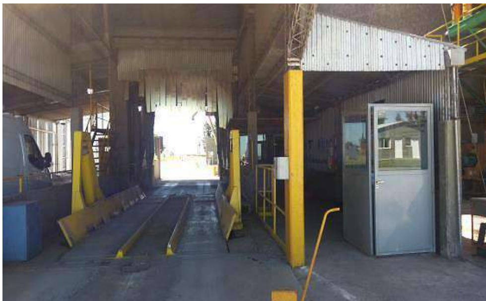
Imagen 09. Sector de descarga de camiones.
