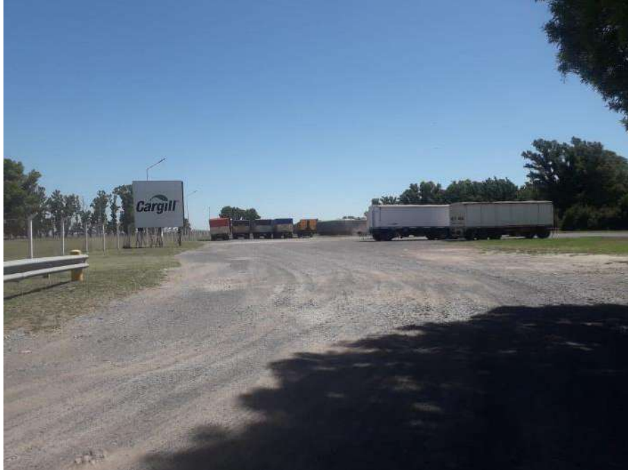
Imagen 07. Playa de Estacionamiento de camiones.
