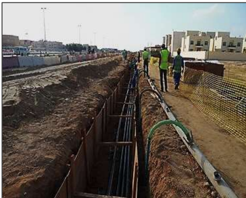
Figura 2. Tendido típico de un CAS
