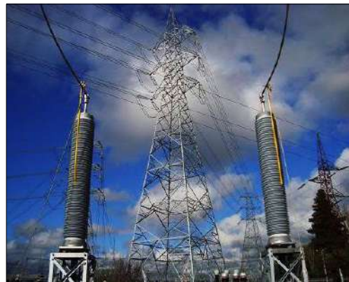
Figura 3. Tipo de terminales aéreas a instalar
