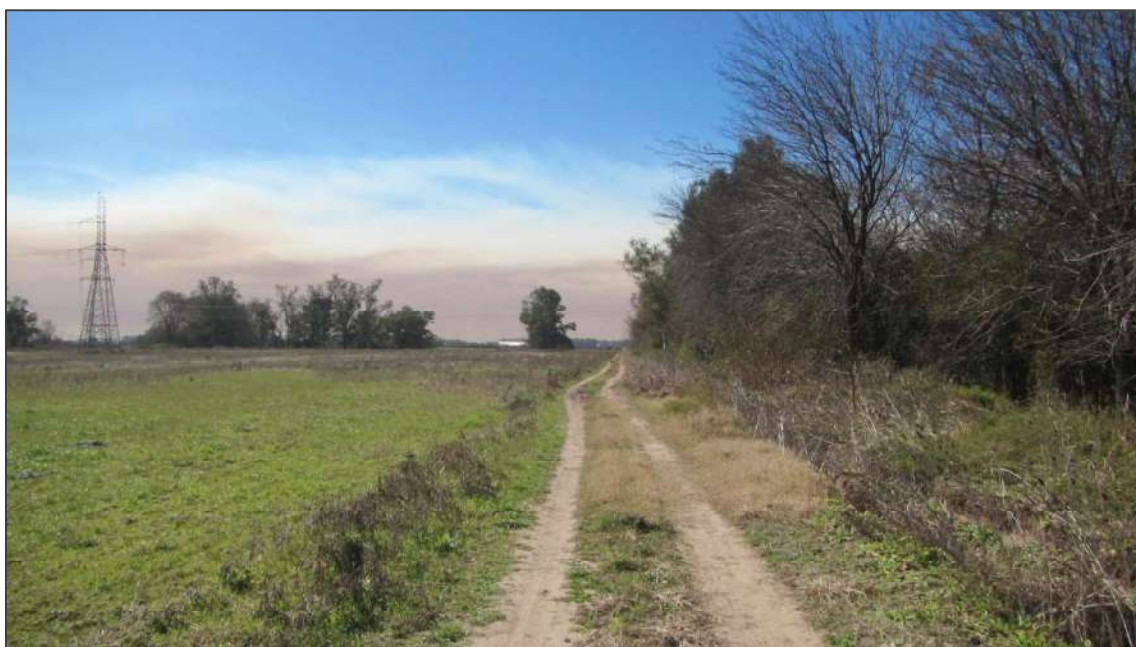
Foto 18. P14 (33°24'47.06"S, 60°10'42.28"O). Alternativa CAS 1 (verde) a campo travesía rodeando la Estación Transformadora Ramallo de Transener para acometer a playa de 220 kV. Vista hacia la Central Termoeléctrica.
