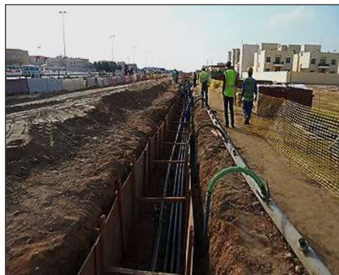
Figura 11. Instalación de Electroducto Subterráneo
