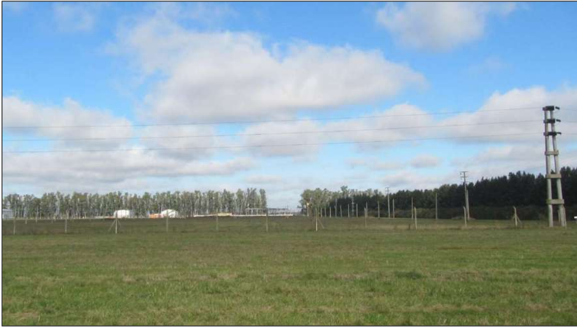
Foto 1. P3 (33°23'34.53"S, 60°08'54.61"O). Vista del predio de la Central Termoeléctrica. Terreno despejado de vegetación y cercado.
