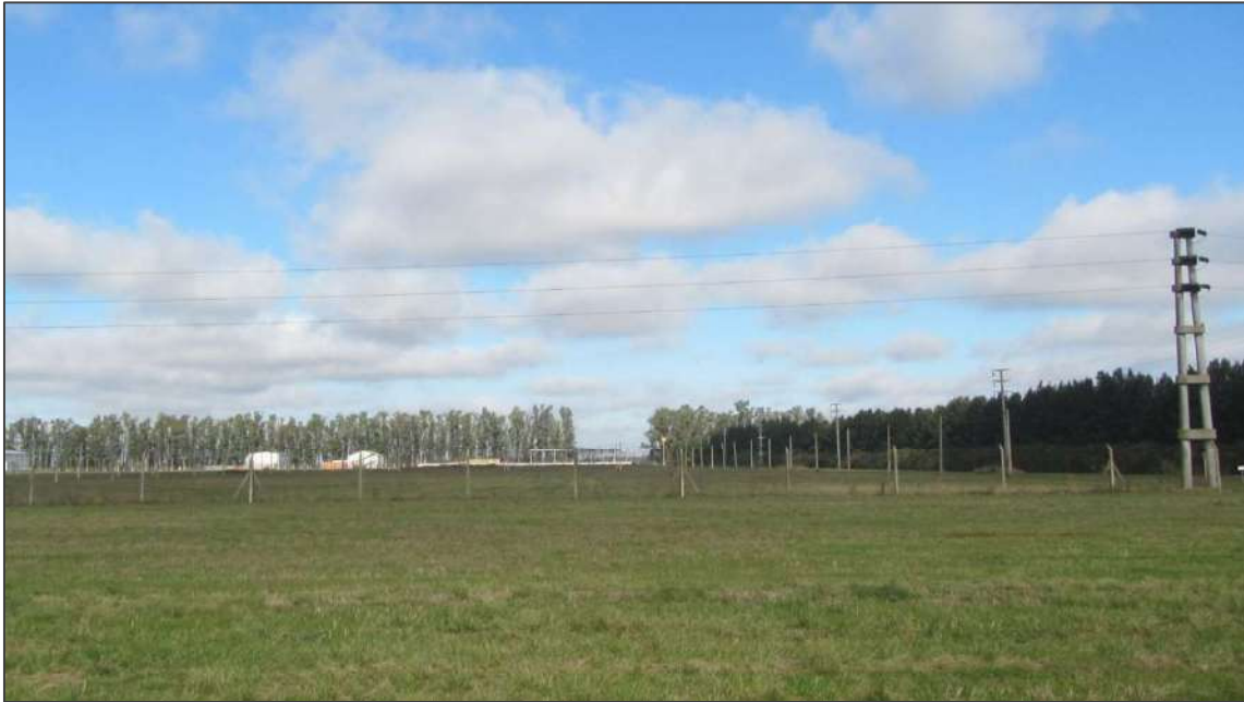
Foto 11. P3 (33°23'34.53"S, 60°08'54.61"O). Vista del predio de la Central Termoeléctrica. Terreno despejado de vegetación y cercado.
