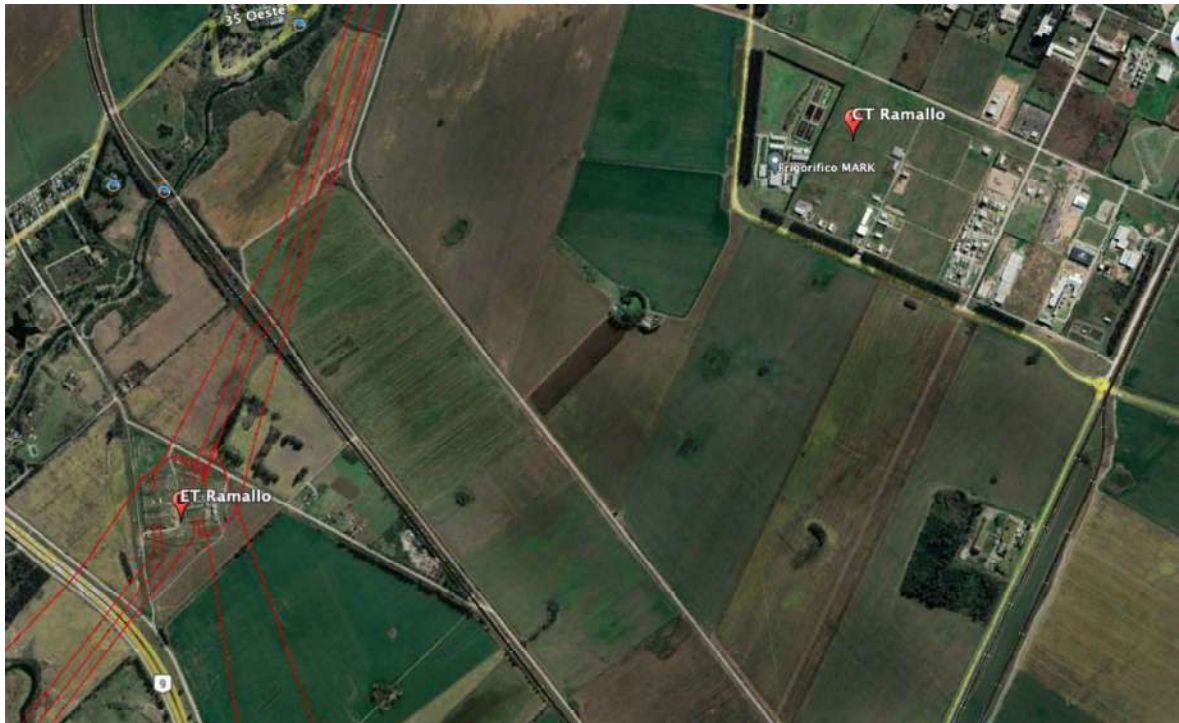
Figura 1. Lugar de emplazamiento de la CT Ramallo y de la ET Ramallo.
