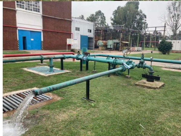
Pozo de Bombeo – AP6
