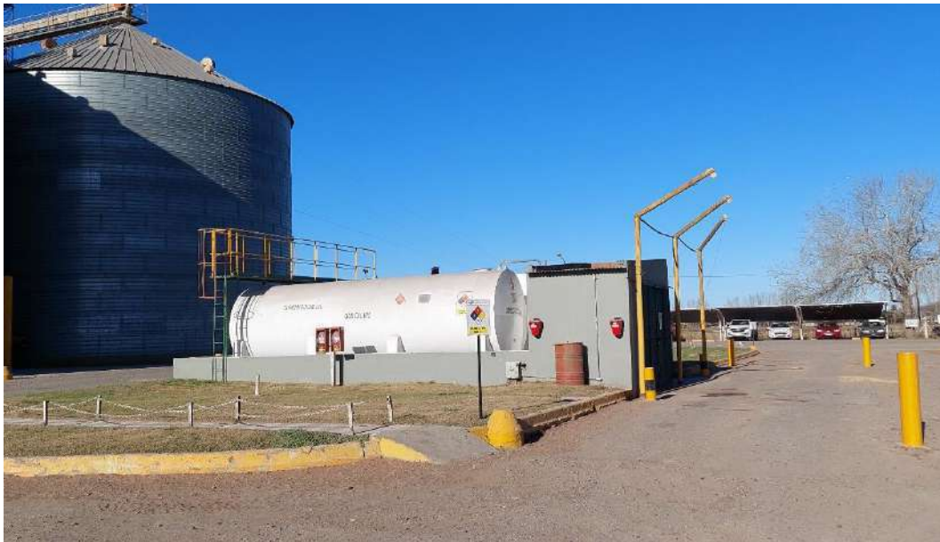
Imagen 13. Almacenamiento de combustible.
