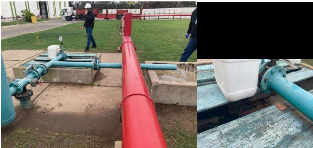
Pozo de Bombeo - AP4
