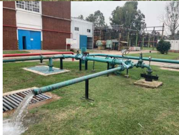
Pozo de Bombeo – AP6
