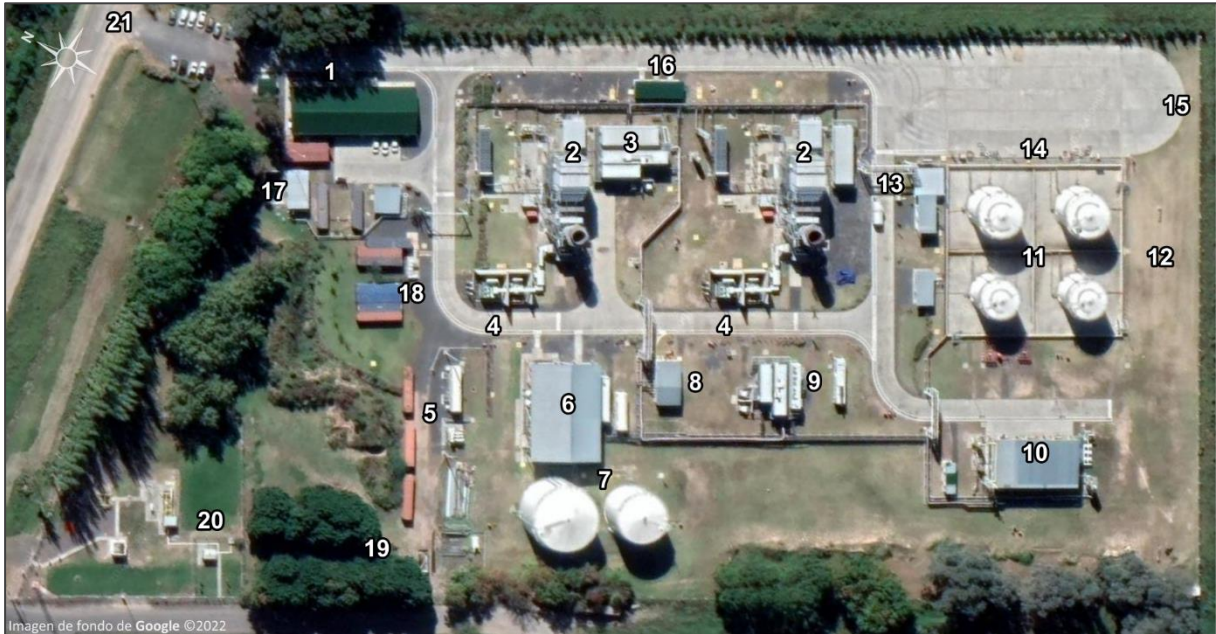
Figura 7-1. Relevamiento fotográfico dentro del predio de la Central Termoeléctrica 127 MW Luján II. Ubicación de los distintos componentes del proyecto.
