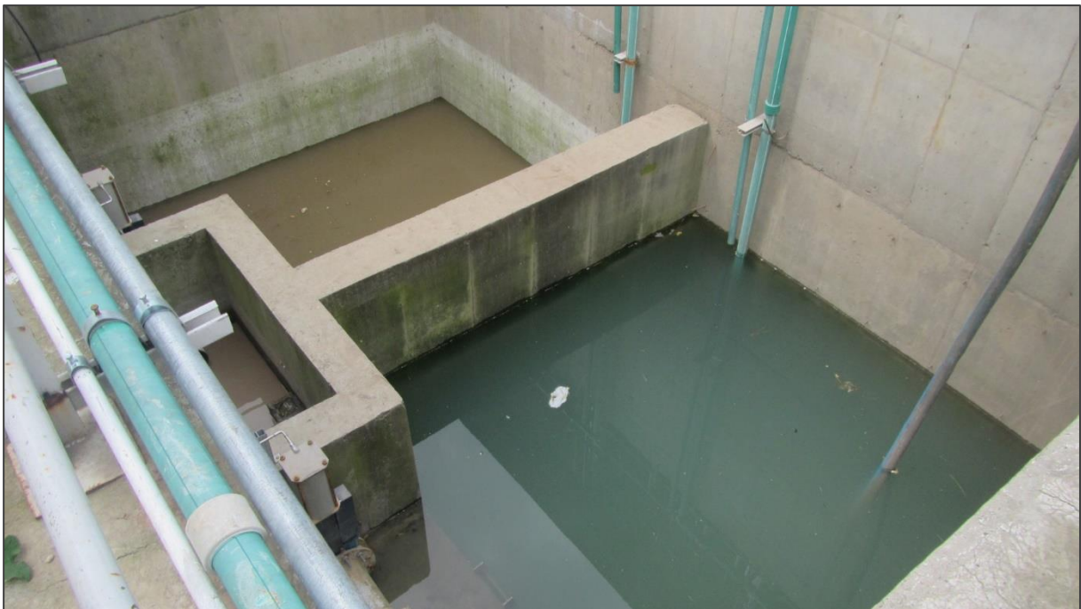
Foto 10. #17. Planta de tratamiento de efluentes.
