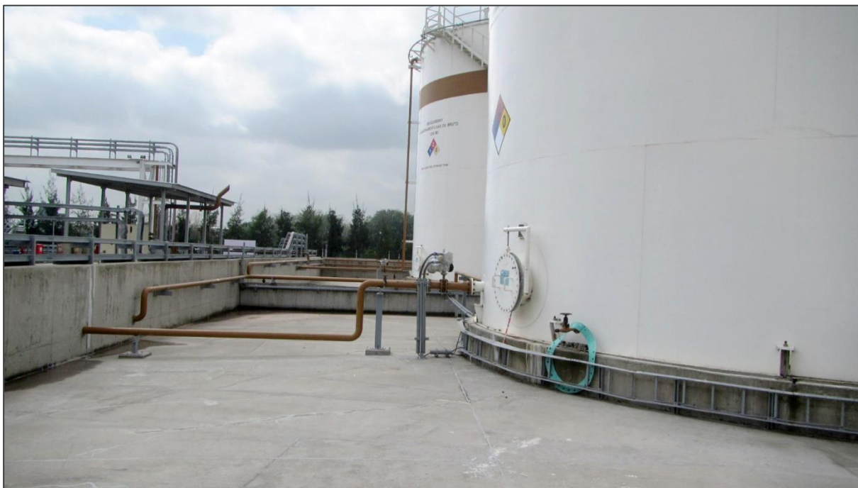
Foto 6. #11. Interior del recinto de contención de derrames de los tanques de gasoil.
