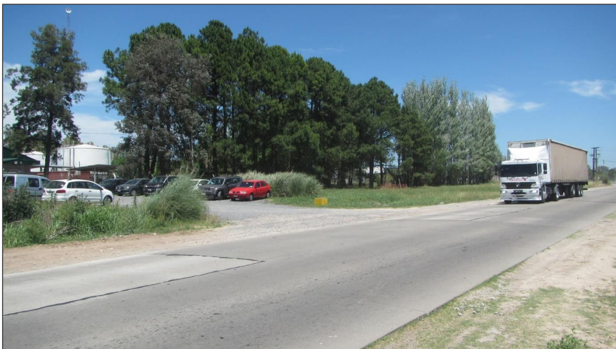
(34°33'22.6"S, 59°02'01.8"O) Ruta Provincial 34 en punto de ingreso a la Central Termoeléctrica. Punto de entrada de los camiones proveedores de gasoil, productos químicos, etc. Será necesario realizar adecuaciones en cuanto a señalamiento y espacio para maniobrar con el objetivo de minimizar el riesgo de accidentes.
