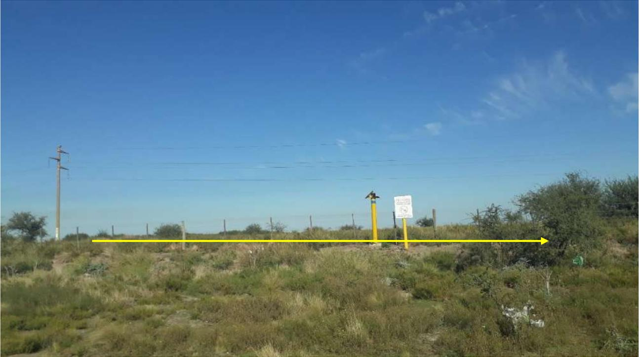
Dirección de la traza, paralela a la línea de alta tensión. Puede verse el cartel de gasoducto de alta presión.
