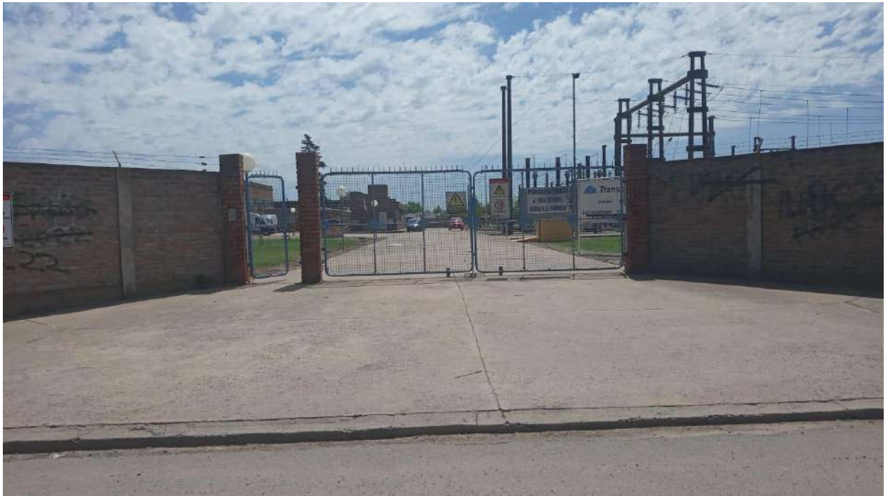
Fotografía 2 – Portón de ingreso a la EETT
