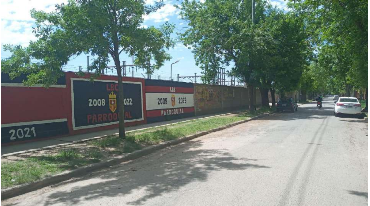
Fotografía 4 – Muro perimetral y forestación de la vía pública
