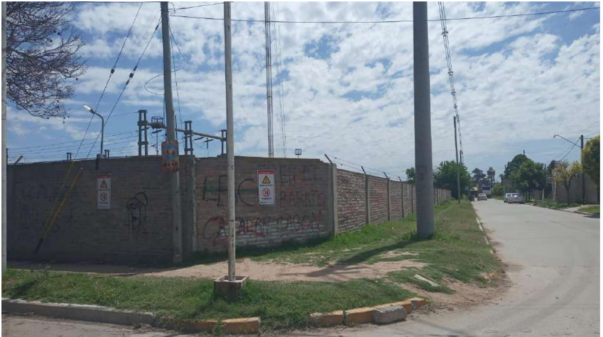
Fotografía 6 – Muro perimetral – Vista de porticos detrás
