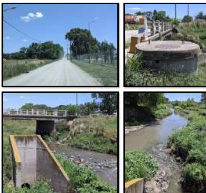
Figura 4: Arriba: Av. Chapaleofu y Boca de Registro. Debajo: Descarga de los efluentes tratados.
