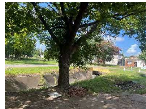
Foto 26: Desde Alfonsina Storni cruce de canal calle Acoyte.
