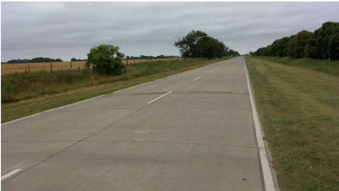
Fotografía 15 – Calle lindera a Traza en Tramo 1
