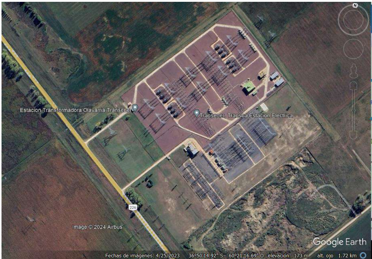
Figura 3.12. Imagen satelital donde se observa la infraestructura de la Estación Transformadora Olavarría, ubicada a la vera de la RN N° 226.
