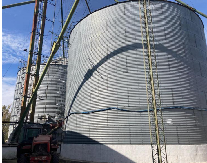
Figura: Vista de los silos pertenecientes a la planta
