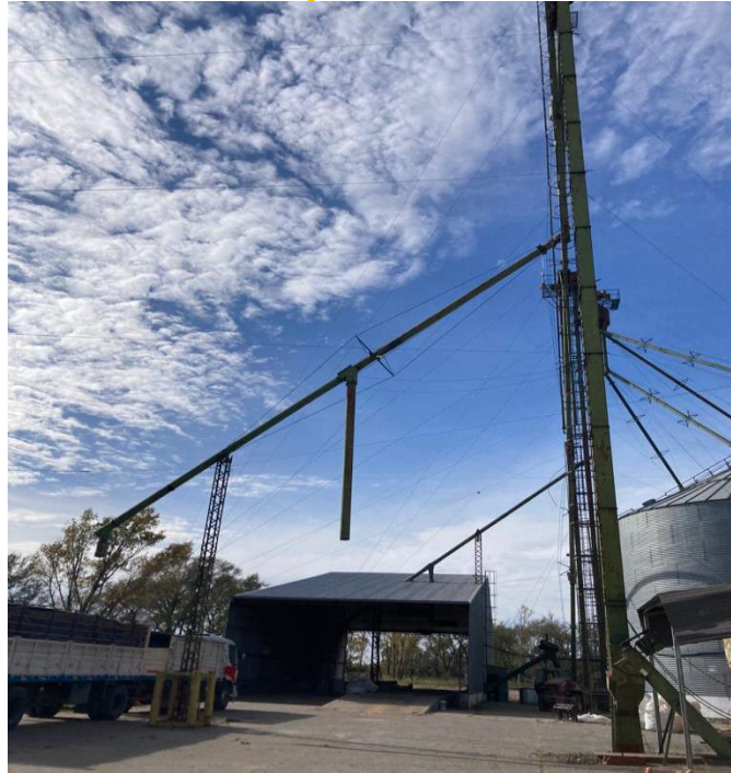
Figura: Vista sector de descarga de los silos de
