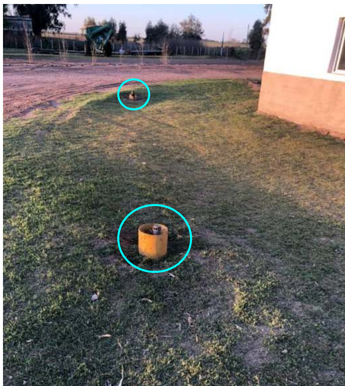
Imagen 13. Vista de riego por aspersión para caminos.
