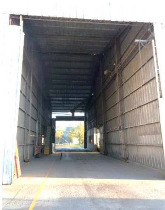
Imagen 5. Área de descarga de camiones.
