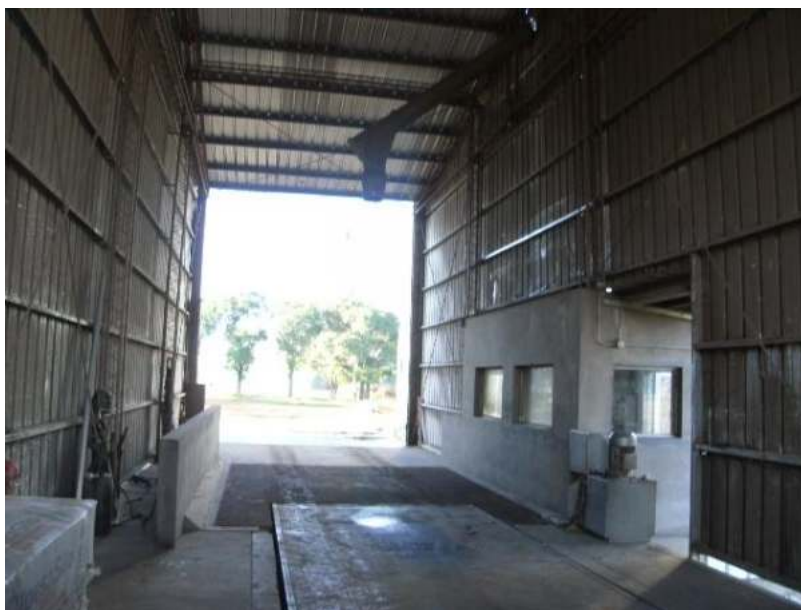
Imagen 8. Sector de carga de camiones.
