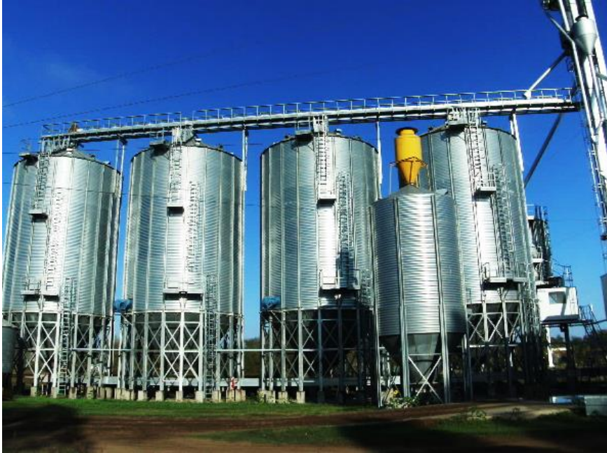
Imagen 6. Silos de almacenamiento.
