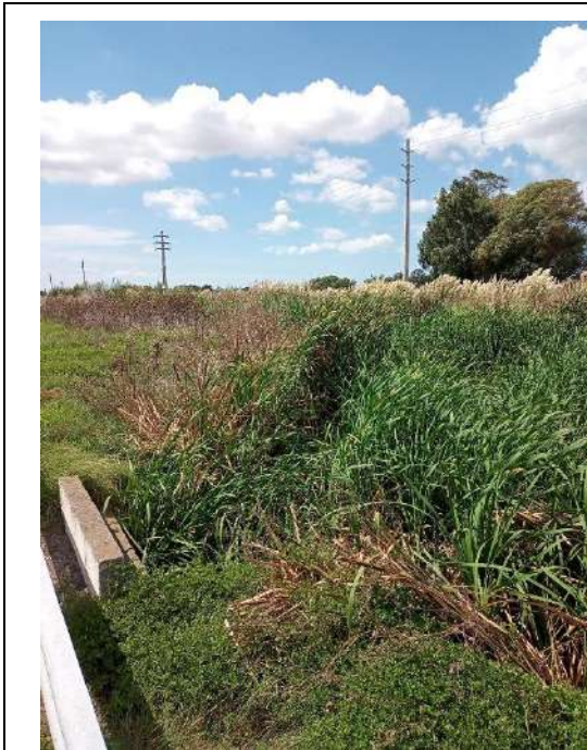
Fotografía 24. Canalización abierta del efluente hacia el arroyo chico.
