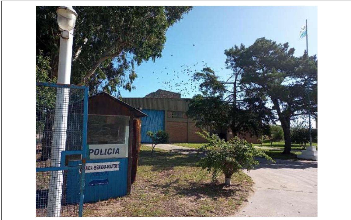
Fotografía 2. Ingreso a planta. Garita de seguridad.
