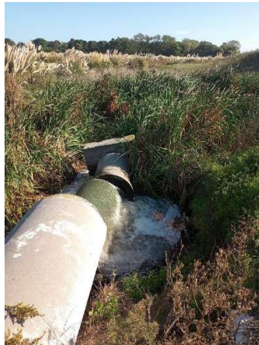
Fotografía 23. Final de canalización cerrada.
