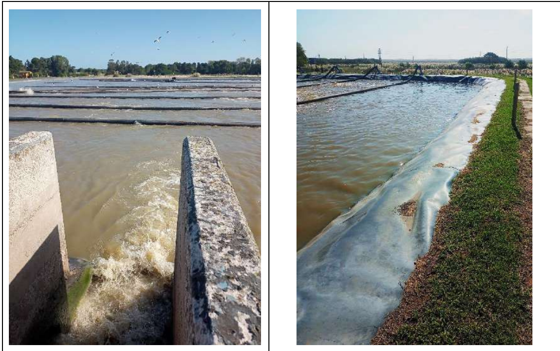
Fotografía 6. Ingreso a Reactor Aeróbico
