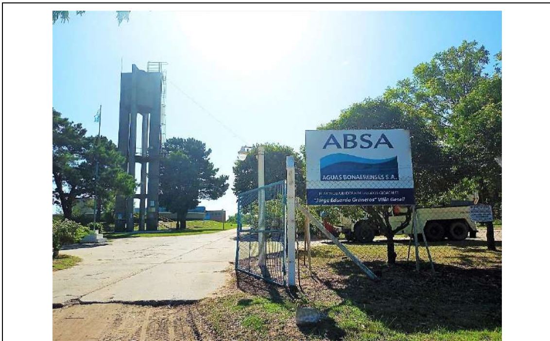
Fotografía 1. Vista general de la planta. Ingreso.
