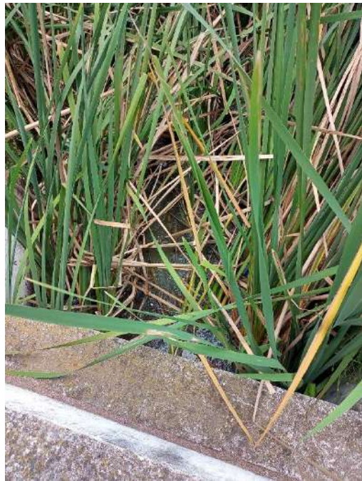
Fotografía 25. Canalización abierta del efluente hacia el arroyo chico.
