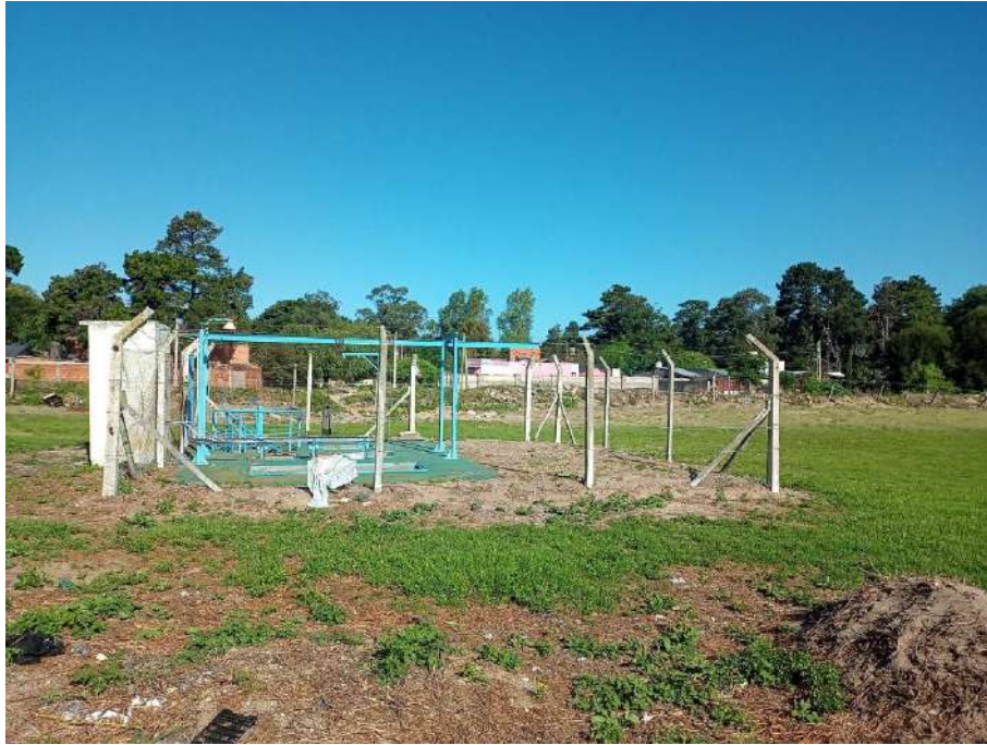
Fotografía 33. Estación de bombeo de barrio adyacente.
