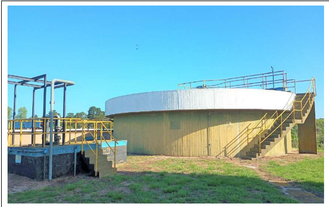
Fotografía 18. Espesado de lodos.
