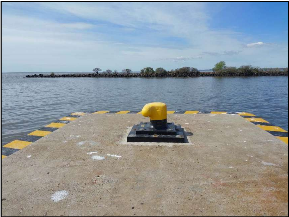
Fotografía N° 7 Bolardo P1. Reemplazo de bitas.
