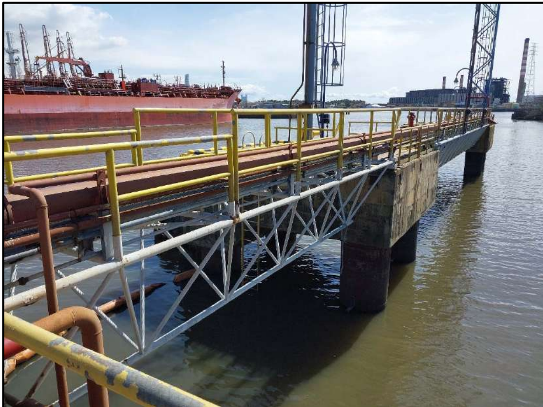
Fotografía N° 24 Estructuras metálicas y hormigón del muelle a ser reacondicionados.
