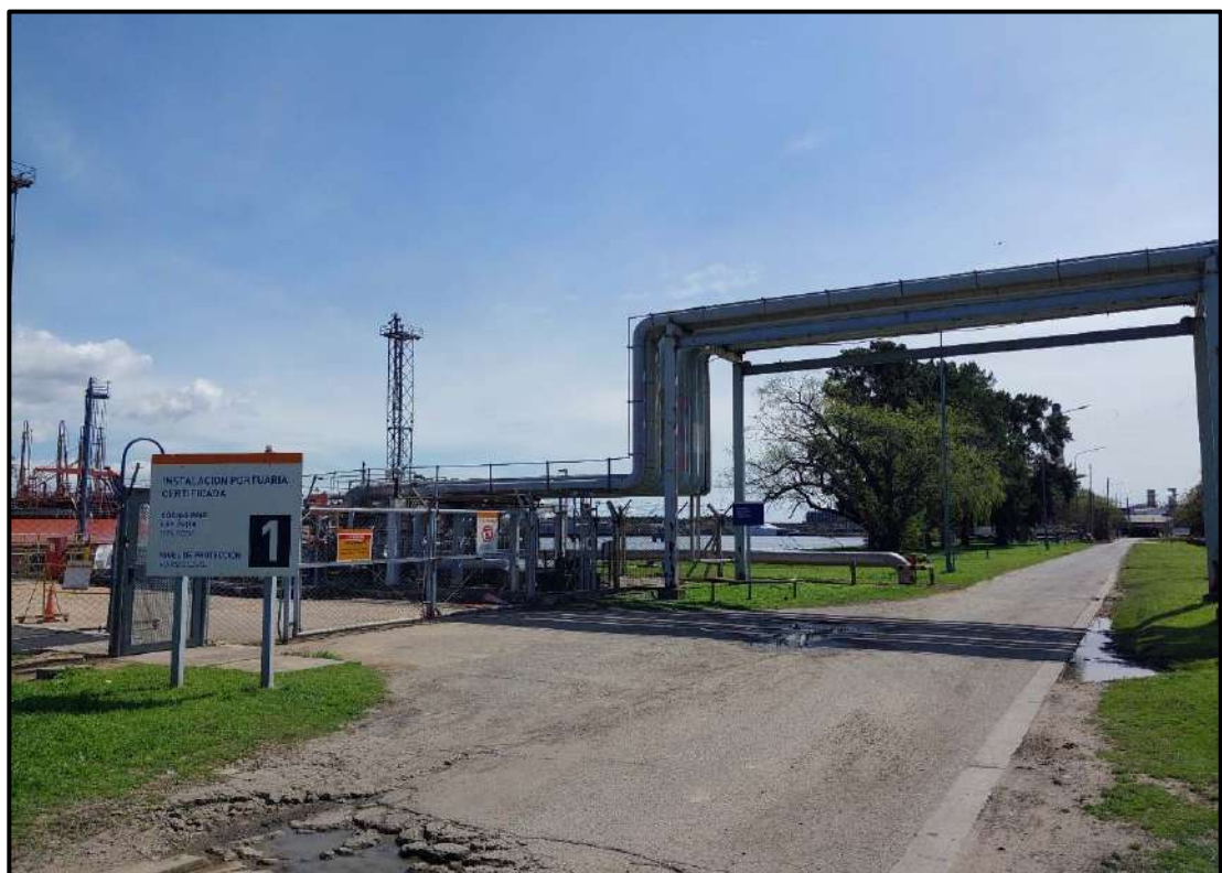
Fotografía N° 14 Ingreso a Muelle F. Vista de camino de acceso.
