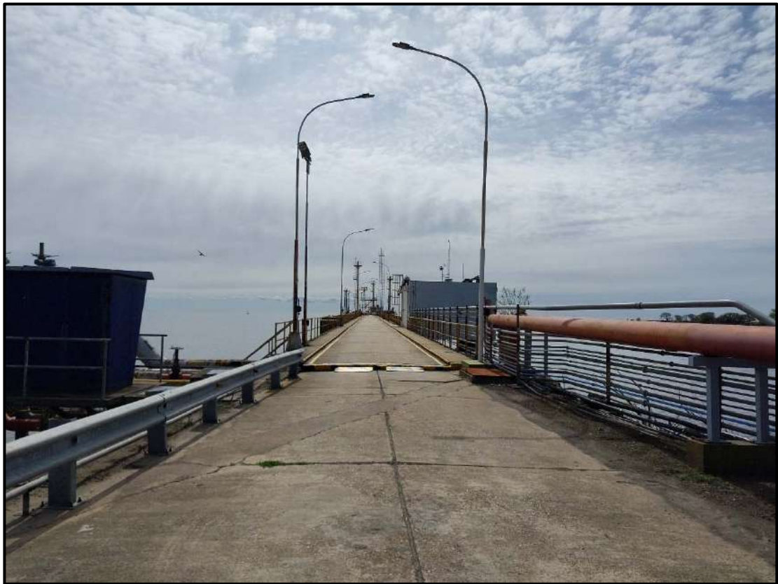
Fotografía N° 1 Ingreso al Muelle Propanero.
