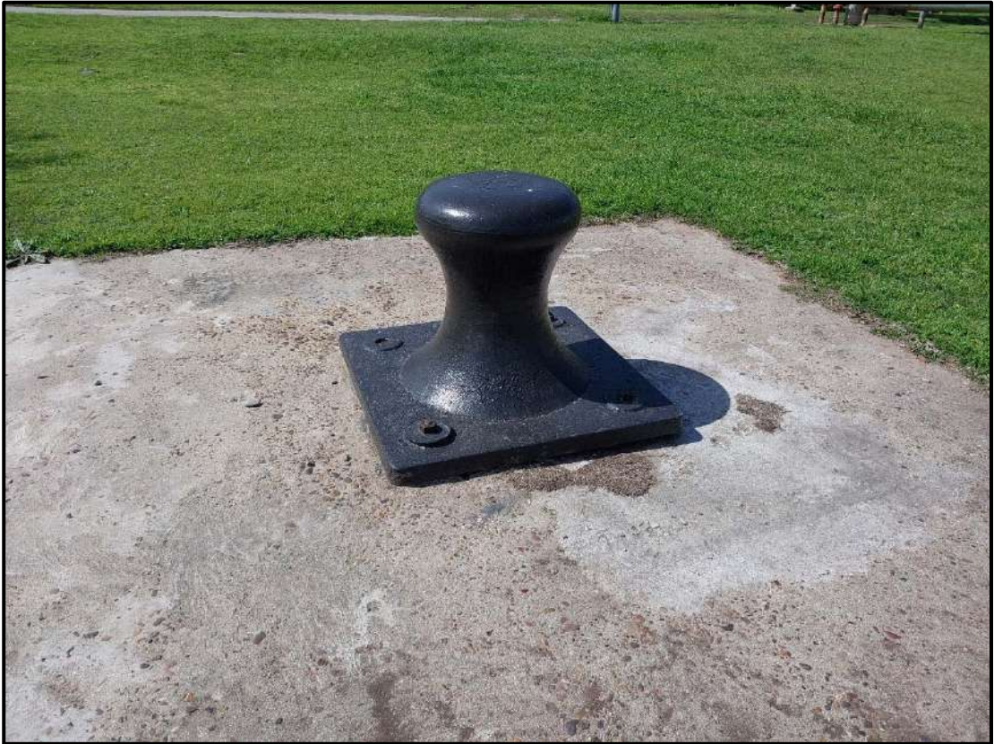
Fotografía N° 15 Bolardo fuera de servicio B2 a ser pintado.
