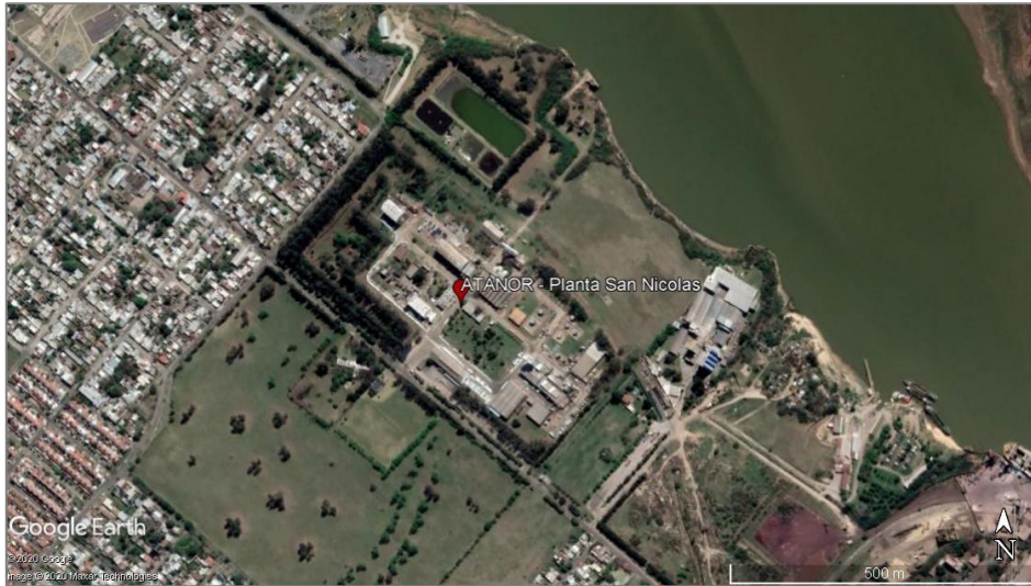
Figura: Imagen satelital con vista del establecimiento Planta San Nicolás.
