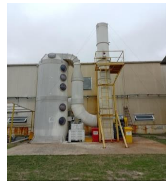
Figura N° 23. Lavador de gases Formación
