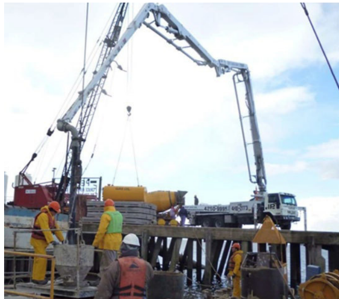
Foto 2.2.4.6.3. Ejemplo de maniobra de hormigonado de pilotes. Fuente: SIDERCA.
