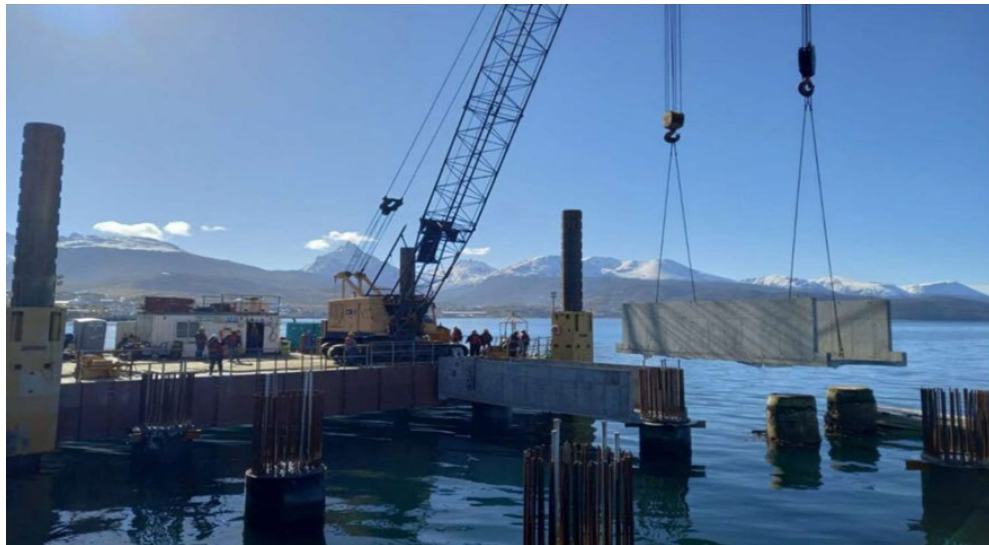
Foto 2.2.4.6.6. Ejemplo de maniobra de izaje y colocación de elementos premoldeados. Fuente: SIDERCA.
