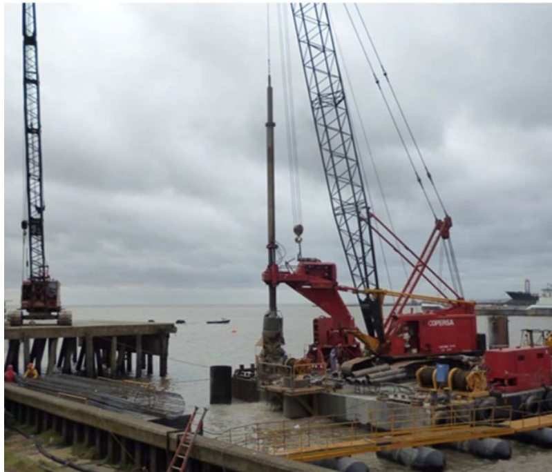
Foto 2.2.4.6.2. Ejemplo de maniobra de perforación de pilote. Fuente: SIDERCA.
