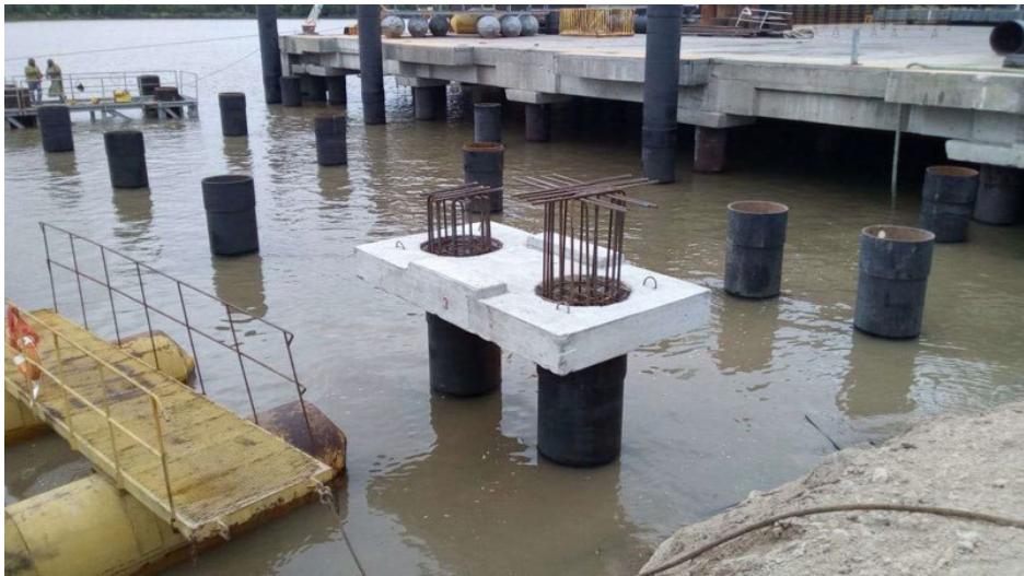
Foto 2.2.4.6.8. Cabezal premoldeado instalado. Fuente: SIDERCA.
