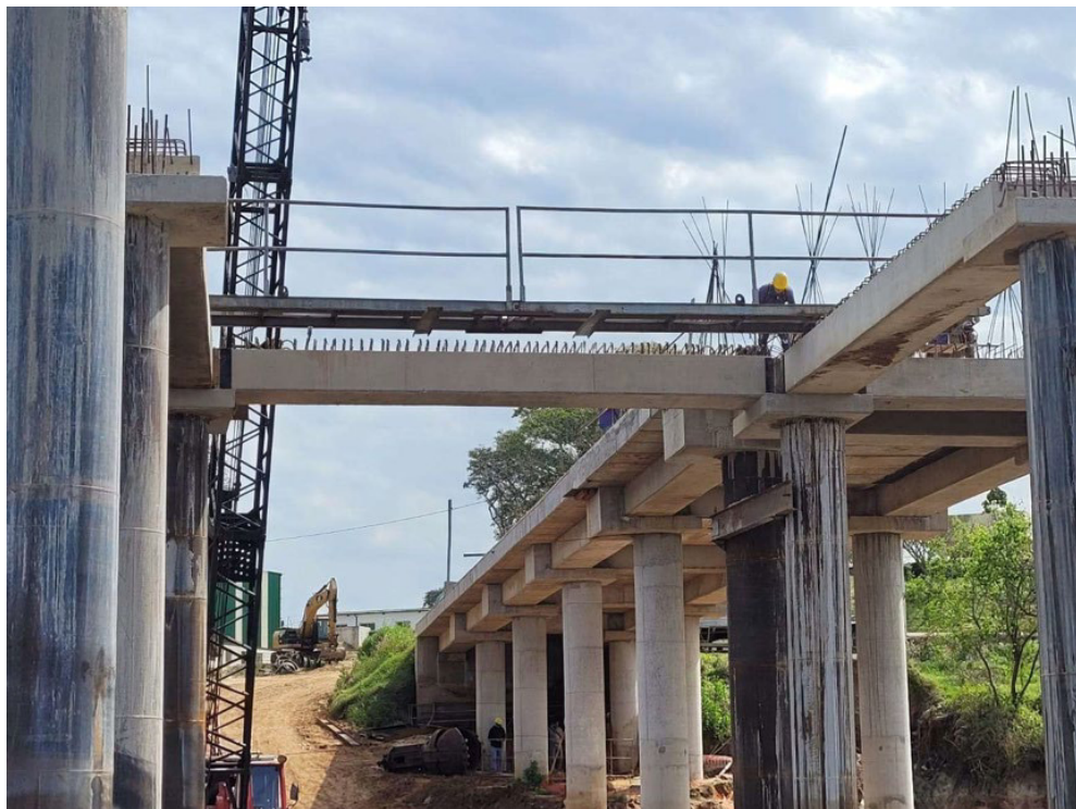
Foto 2.2.4.6.7. Ejemplo de vigas premoldeadas instaladas. Fuente: SIDERCA.
