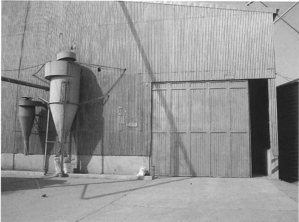
Detalle del cerramiento en el sector de carga y descarga del cereal y vista de los ciclones de captación de polvo de la chamiquera
