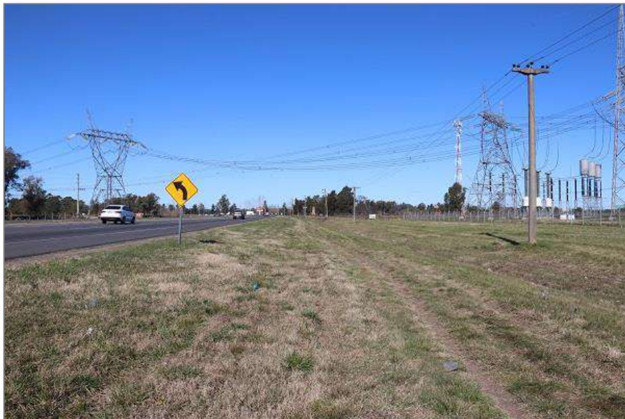
Fotografía: Vista de la zona donde se emplazará el electroducto proyectado.
